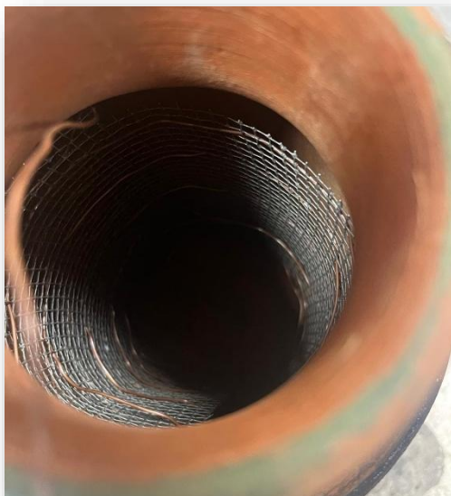
Fig. 2. Instalación de malla de acero inoxidable en la superficie interior del recipiente de arcilla.
