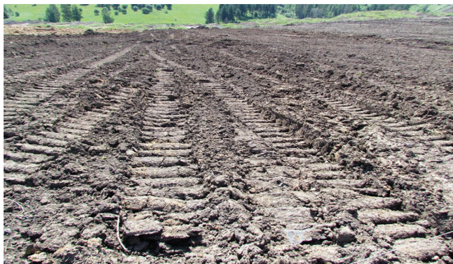
Рисунок 1. Послойное нанесение потенциально-плодородного и плодородного слоев почвы
