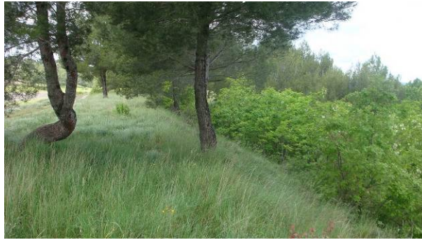
FIGURE 1. Drageons de robinier, ayant colonisé très densément l'ensemble du talus de digue suite à l'abattage de l'arbre-mère, qui provoquent une forte gêne de la surveillance visuelle.
