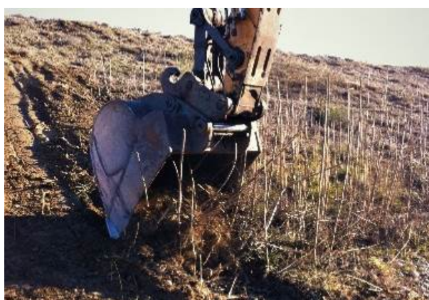
FIGURE 7. Éradication des drageons d'ailante par purge des racines traçantes à la pelle mécanique sur le talus d'une digue de canal de la Durance.
