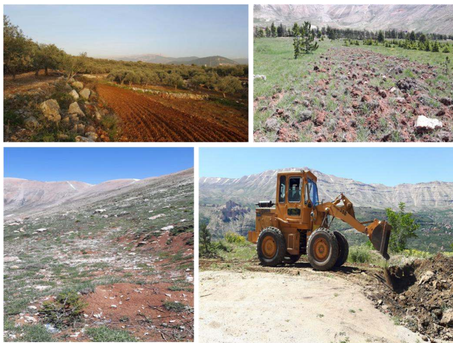
Figure 19 : Exemples de sites sélectionnés et de travaux réalisés sur les sites : de gauche à droite : Kafaraaka (320 m), Arz1 (1980 m), Arz2 (2330 m) et Becharré (1570 m). Phase préparatoire des sites expérimentaux : suppression de la totalité des végétaux présents, décompactage du sol, labour du sol jusqu'à 40 cm de profondeur, évacuation des pierres, ratissage.
