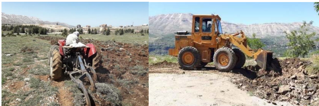
Figure 52 : Décompactage du sol à l'aide de différentes méthodes : charrue tractée à gauche sur le site d'Arz 1 (1980 m) et minipelle à droite sur le site de Becharré (1570 m), en préparation à la plantation.
