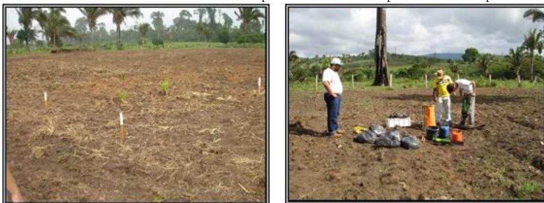
Figura 2. Após o preparo da área, balizamento e piqueteamento das parcelas do experimento e preparação para a semeadura de milho e da Urochloa brizantha utilizando plantadeira manual do tipo matraca. Parauapebas-PA.
