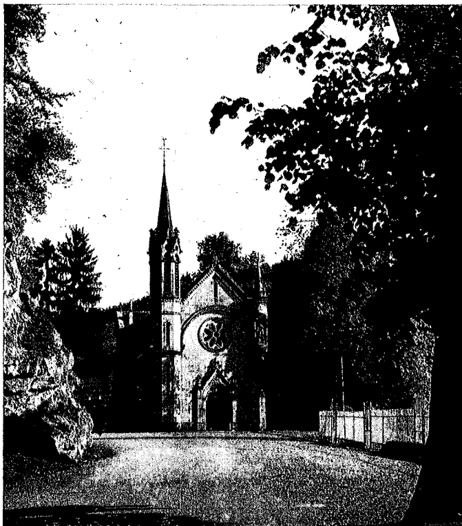
Eglise de Lasauvage. A gauche la partie inférieure du bloc calcaire dont mention. L'étang est situé à droite de la route.
