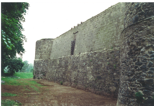
Figuur 2. Zuidkant van de weermuren voor en na de restauratie, respectievelijk najaar 1999 (boven) en zomer 2000 (onder). De weelderige begroeiing van houtige gewassen werd verwijderd. In enkele zones van de verticale muren van de omwalling die nog in goede staat waren werd de begroeiing van kruidachtige planten niet verwijderd.
