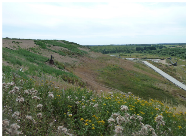
Figure 2. Pente Ouest du casier n° 1 (Habay, 24 juillet 2015).
