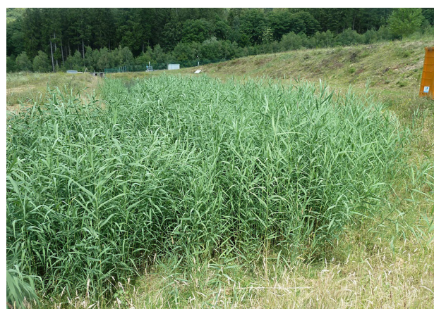
Figure 11. Bassin d'orage peuplé de grandes glycéries (Tenneville, 17 juillet 2014).
