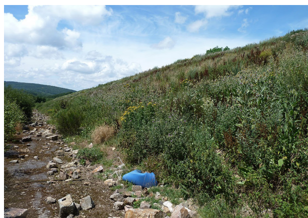
Figure 8. Pente Sud des sous-casiers n° 1 et 2 (Tenneville, 23 juillet 2015).
