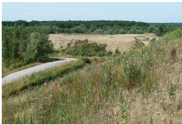
Figure 4. Stock de remblai vu du casier n° 1 (Habay, 24 juillet 2015).
