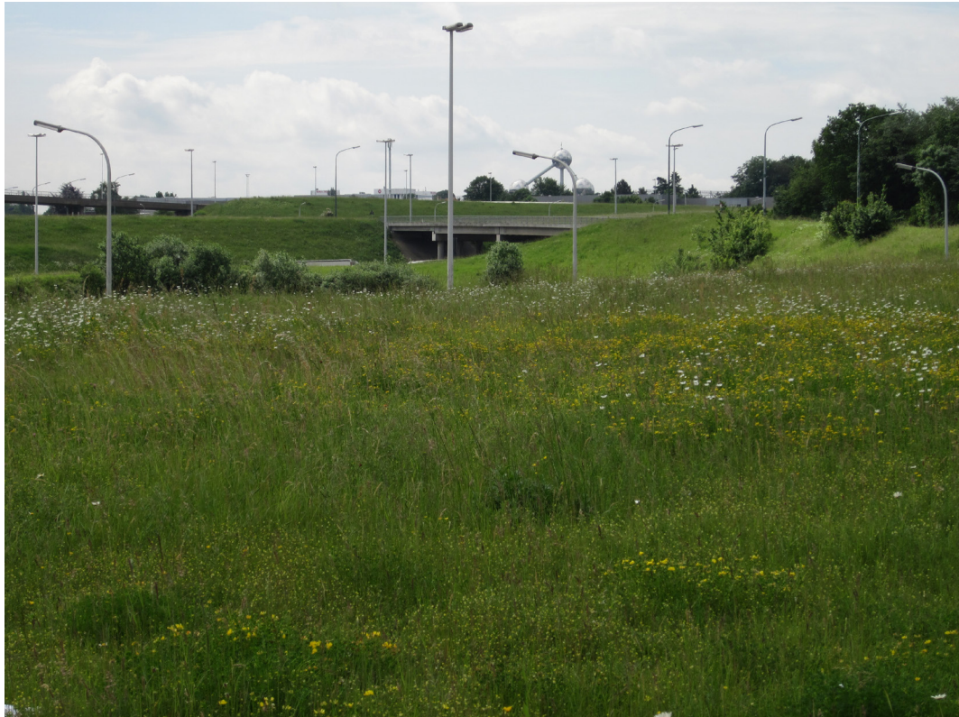
Figuur 2. Zicht op een deel van de verkeerswisselaar, met op de achtergrond het Atomium.
