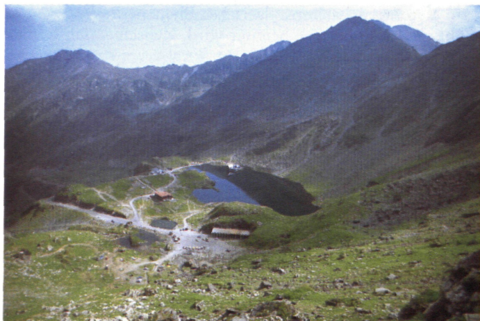
Abb. 5: Der Bulea-Kessel mit dem Schutzhaus am Bulea-See in 2027 m, der Trans-Fogarasch- Straße und der Ein- fahrt zum 890 m langen, unbeleuch- ten Transfogarasch- Tunnel.
