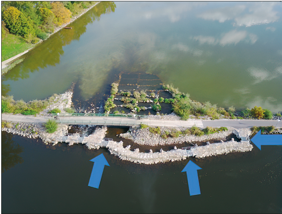
Abb. 7: Der Altmarm Altenwörth wird seit Errichtung des gleichnamigen Donaukraftwerks (1986) über eine Traverse rückgestaut. Im Rahmen des Projekts LIFE Network Danube Plus wurde die bestehende Fischwanderhilfe (Beckenpass) verlängert und mit drei Einlaufbauwerken (blaue Pfeile) versehen. Je nachdem welches der drei Bauwerke geöffnet ist, stellt sich im Altmarm flussauf der Traverse (Bildvordergrund) ein hoher, mittlerer oder niedriger Wasserstand ein. Die so erzielten jahreszeitlichen Wasserstandsschwankungen betragen im Altmarm ca. 0,5 m und erzeugen großflächige wechselfeuchte Zonen auf den neugeschaffenen Flachufem (siehe Abbildung 2). – Fig. 7: Since the construction of the Danube power plant Altenwörth (1986), the oxbow lake Altenwörth has been impounded via a traverse. Within the framework of the LIFE Network Danube Plus project, the existing fish migration facility was extended and was provided with three inlet structures (blue arrows). Depending on which of the three structures is open, the water level in the oxbow lake upstream of the traverse (foreground) is high, medium or low. The achieved seasonal water level fluctuations amount to approx. 0.5 m in the oxbow lake and create large alternating wet zones on the newly created shallow banks (see Figure 2).
