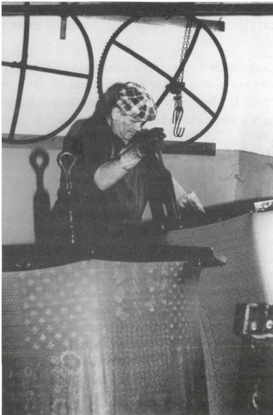
Abb. 1: Färbermeister Josef KOÓ (Steinberg/Rabnitz, Bgld.) färbt Blaudruckstoffe mit Naturindigo.
