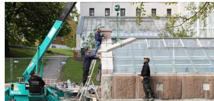
Grorudgranitt ble brukt i 2009, akkurat som i 1868. Stenen ble slipt i Polen og montert etter de opprinnelige tegningene, etter at tilbygget fra 1930-tallet var fjernet.
