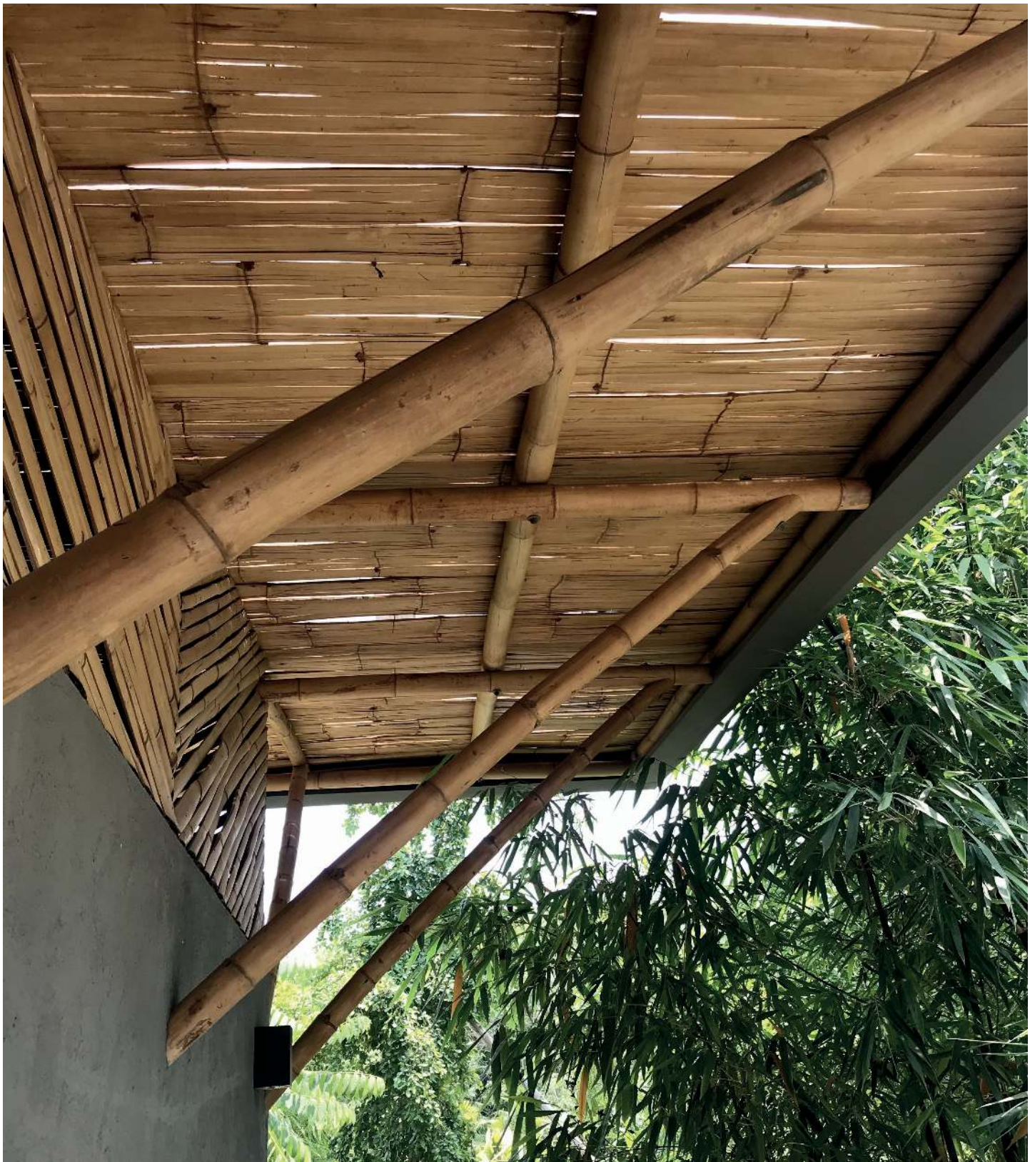
Figura 6: Plafón de esterilla y soportes hechos con Bambusa oldhamii Munro en estructura de carga. Hotel Gran Tamoanchan, Xolol, San Luis Potosí, México.
