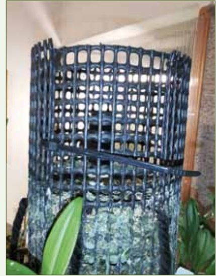
Laubgitter mit angesetztem Stück bei Standrohr > DN 70
