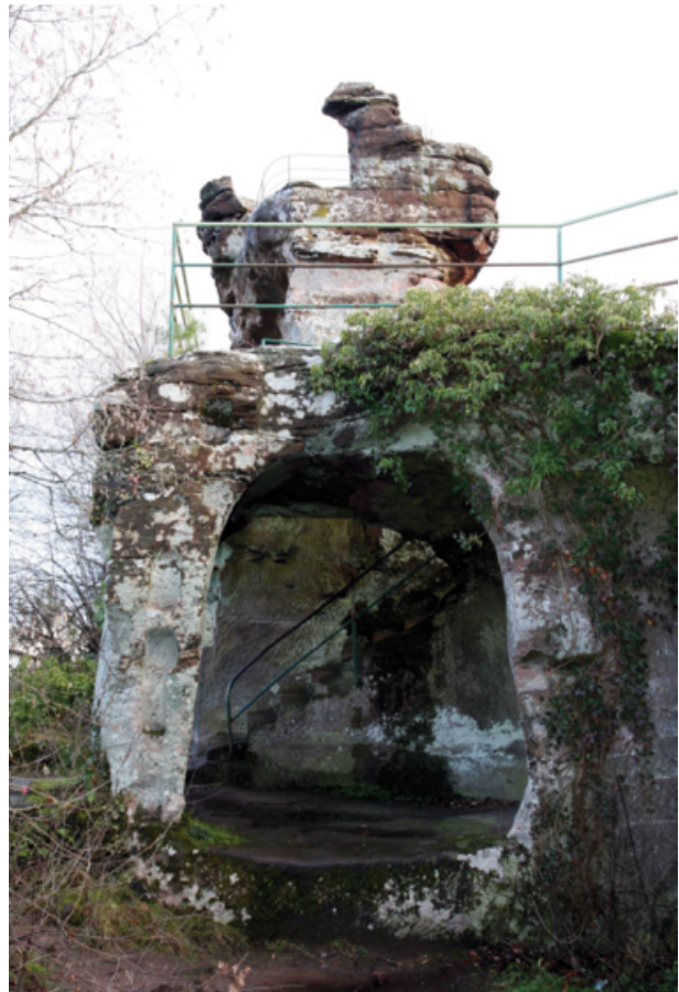
Abb. 1: Ansicht eines Teils der Oberburg aus Westen. Foto: V. JOHN
