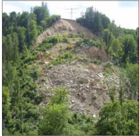
Abb. 2: Bergsturz vom 6. März 2017 oberhalb von Bad Boll: 112.600 Kubikmeter Gestein, die nach dem Hangrutsch ein fragmentiertes Gesteinsvolumen von 152.700 Kubikmeter einnehmen (GREINER 2020). (Foto A. Reif, 21.4.2017)
