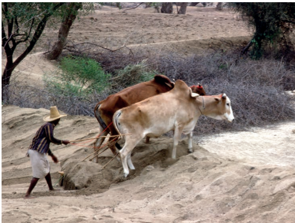
Abb. 7: Errichtung von Ableitdämmen und Wallfeldern für die Flutbewässerung im Becken von At Tur. Fig. 7: Construction of deviation ditches and walled fields for flood irrigation in the basin of At Tur.
