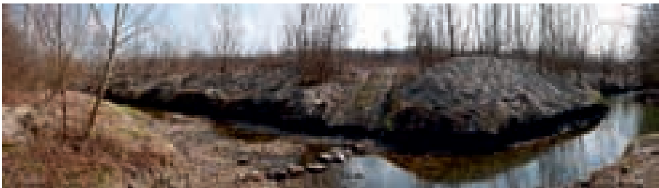
Abb. 15. Wiederholt notwendige Sandbaggerungen im westlichen Teil des neuen Seitengerinnes in Gosdorf (Foto: A. Drescher, 10.3.2016).
