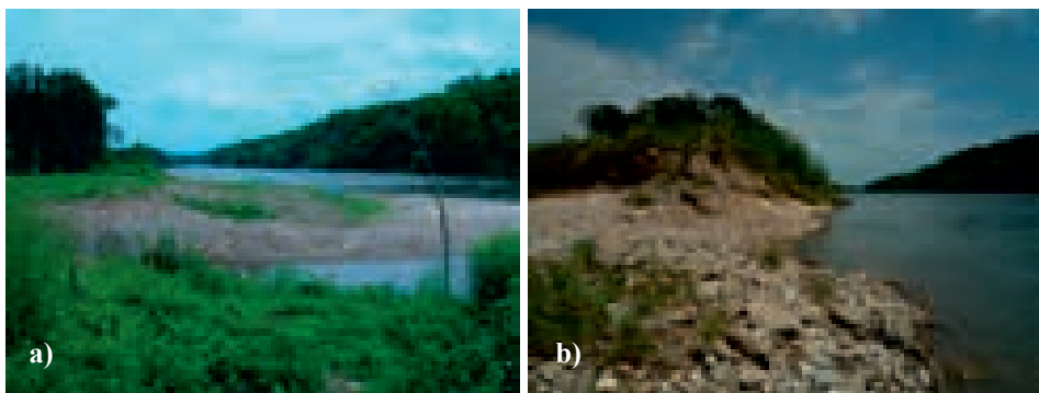
Fig. 13. Gosdorf: a) unterspültes Steilufer der Mur nach Entfernung der Ufersicherung und b) abgeflachtes nicht verbautes Murofer mit Pioniervegetation (Fotos: A. Drescher).
