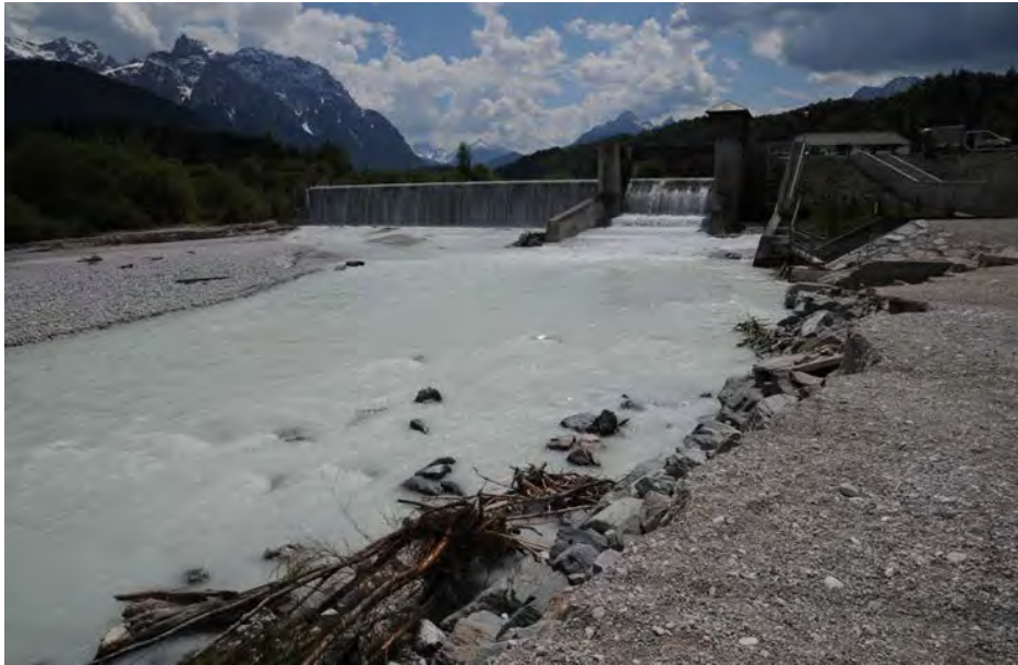
Abb. 9. Krüner Wehr, das zur Ausleitung einer Wassermenge von bis zu 25 \text{ m}^3/\text{s} über einen Kanal in den Walchensee gebaut wurde (7. Juni 2013; Foto P. Poschlod).
