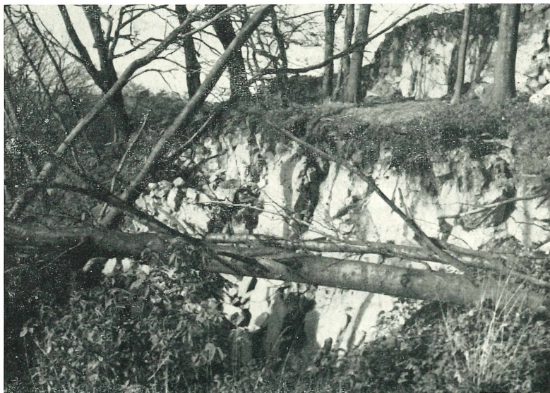
Diese Spalten auf der „Kalbe“ sprechen eine deutliche Sprache zum Bergbau auf dem „Hohen Meißner“. Foto: G. Heintze.
