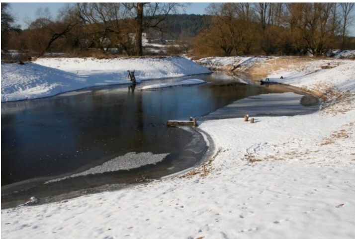
Abb.17: Aus- gleichsmaß- nahme durch die Deichnachschrü- gung in Hirschaid
