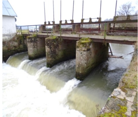
Abb. 23: Doppelter Sohlabsturz durch das Wehr
