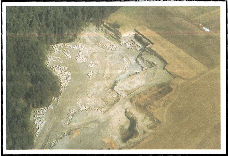
Nordteil des Steinbruches „Bayerische Schleifsteinwerke“ aus der Vogelperspektive.
