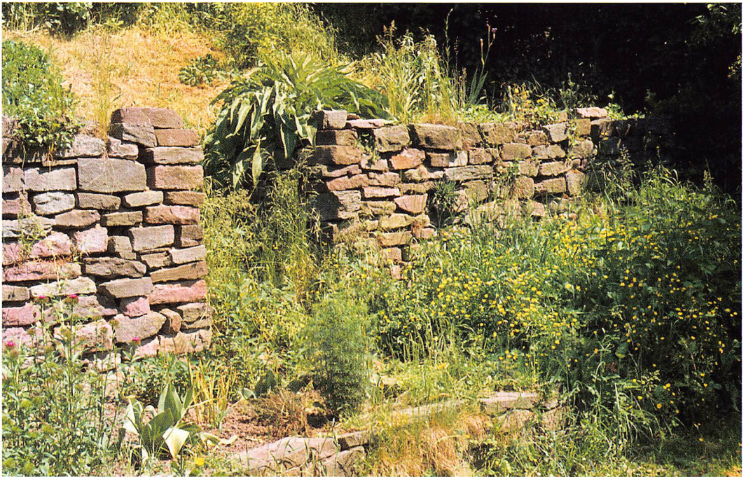
Abb. 51: Fugen von Trockenmauern bieten zahlreichen Bienen und Wespen gute Nistmöglichkeiten (Achim-Uesen; Foto: H. Riemann).
