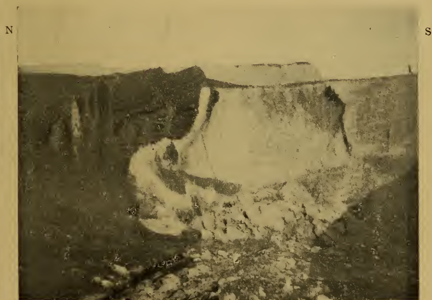
Abb. 2. Geschiebelehm-Einpressung in die Braunkohle.
