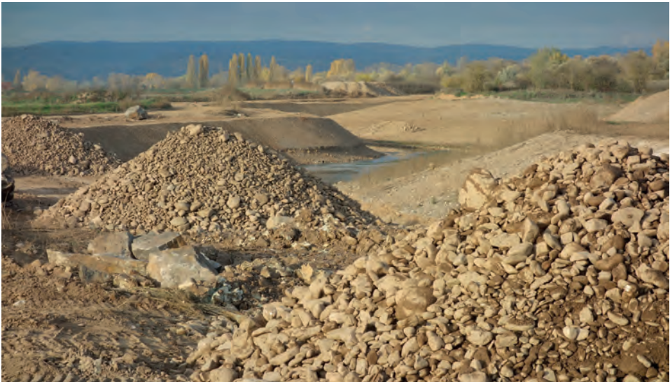
Abb. 1: Bau des neuen Seitenarms der Nahe bei Bretzenheim. Die Aushubmaterialien wurden z. T. für den Bau des Riegeldeichs und für eine Deichertüchtigung bei Langenlohnshem eingesetzt (Foto: A. OESAU, 21.09. 2015).
