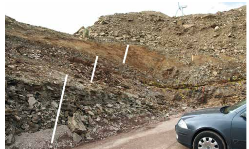
Abb. 1: Die Aufschlussituation an der Windrad-Baustelle auf der Höhe zwischen Obermoschel und Lettweiler im Jahr 2013. Die Balken markieren jeweils unterschiedliche Fazies: Eine siltig/sandige Wechselfolge – fluviale Ablagerungen auf Überflutungsflächen (links), laminierte Ton- und Siltsteine, die Sedimente des eigentlichen Obermoschel-Sees (mittig) und den überlagernden, intrusiven Andesit (rechts).
