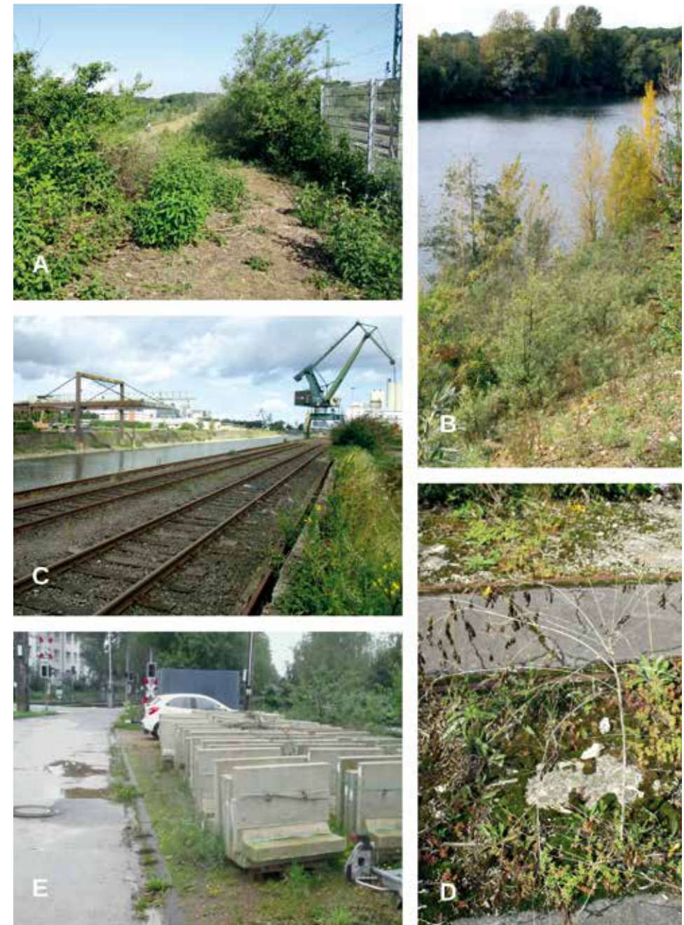
Abb. 3: Beispiele von Fundstellen im südlichen Nordrhein-Westfalen: Obere Berme(n) nahe der ICE-Trasse bei Köln-Gremberghoven (A) und Blick auf die untere Berme mit Sanddorn-Bepflanzung und beginnender Sukzession auf der Böschung (B); Hafengebiet in Köln-Deutz (C) mit Beispiel zur Fugenflora mit Sedum und Färberwaid (D); Materiallager nahe der Straßenbahn-Endhaltestelle in Köln-Thielenbruch (E) (Fotos: H. KAPPES).
