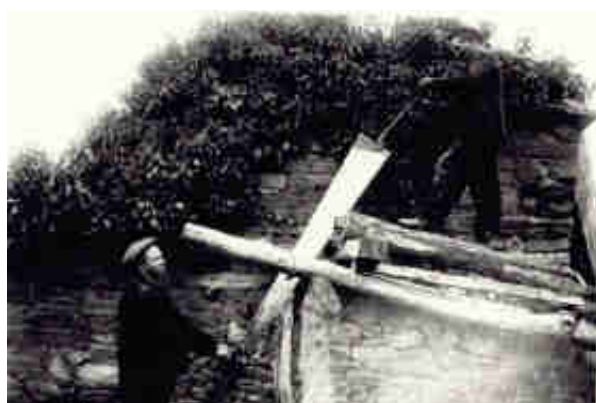
Fig. 4. Carpinteros cortando vigas de roble hacia 1924, Santa Colomba de Somoza.
