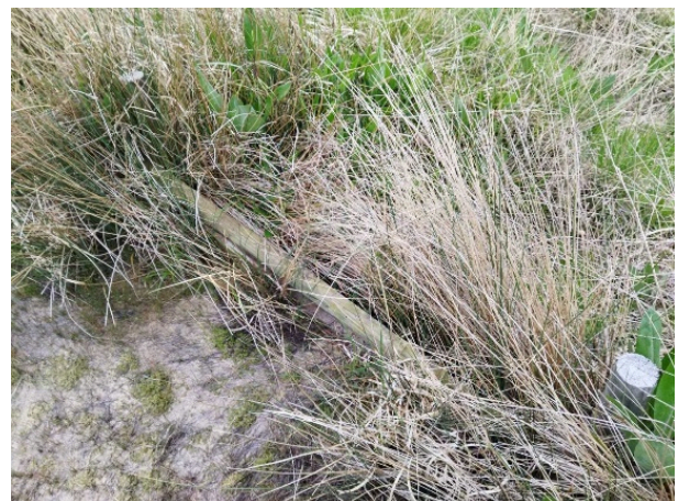
Fig. 4. Detalle de un dique de contención de madera en el borde del tremedal neutro-basófilo de Abiada.
