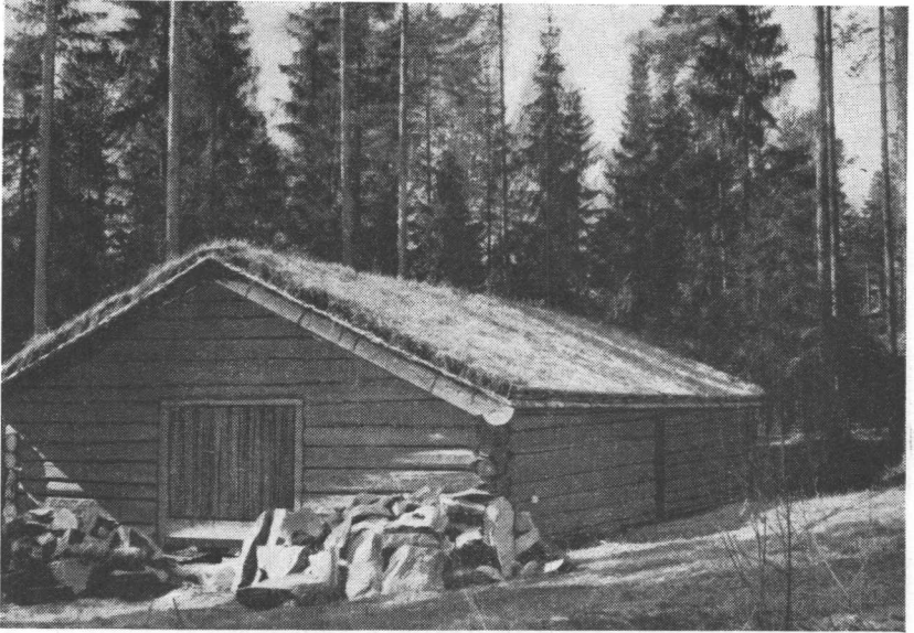
Fig. 4. Sommerfjøset fra Østerhaug, nå på Glomdalsmuseet. I en stokk over døren stod innhogd: Bygget 1671, flyttet 1796. Summer stable from Østerhaug, now at the Museum of the Gloma Valley. In a beam above the door had been carved: Built 1671, moved 1796.
