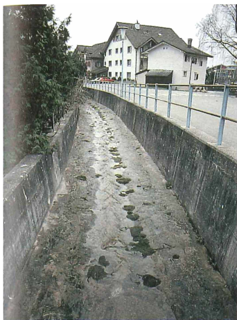
Abb. 3: Deutlich sichtbar ist die geringe Wassertiefe in den mit Beton verbauten oberen Abschnitten des Seveler Baches.
