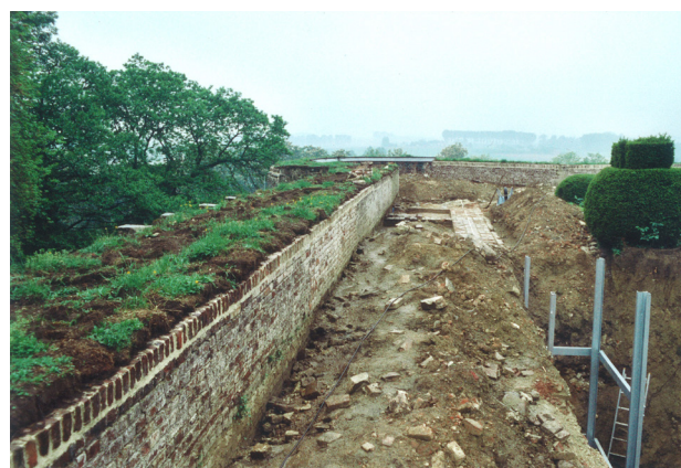
Figuur 3. De vegetatie op de bovenkant van de weermuren werd verwijderd in de vorm van zoden, die na de restauratie opnieuw aangebracht werden (links van de bakstenen muur). Foto: zomer 2000.
