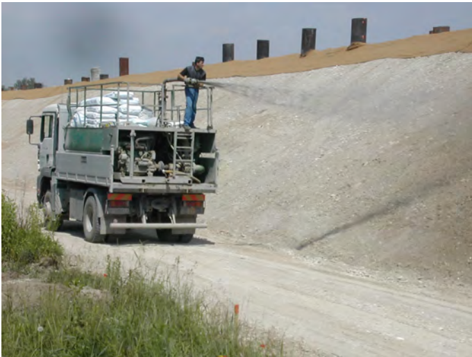
Abb. 2: Ausbringung des Saatgutes (Strohmulchsaat) im Anspritzverfahren ( www.hydrogreen.at ). An der Hangschulter: Kokosmatten gegen Erosionen. Juni 2005.
