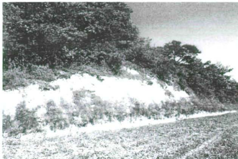
Abb. 6.18: Westansicht der Konglomerat- Böschung (2) bei Heinigstetten. Foto: DENK (1999)
