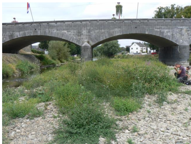
Fig. 2. – Banc d'alluvions (habitat 3270) au niveau des piles d'un pont sur l'Ourthe à Hamoir (photo : Grégory MOTTE, 19 août 2022).
