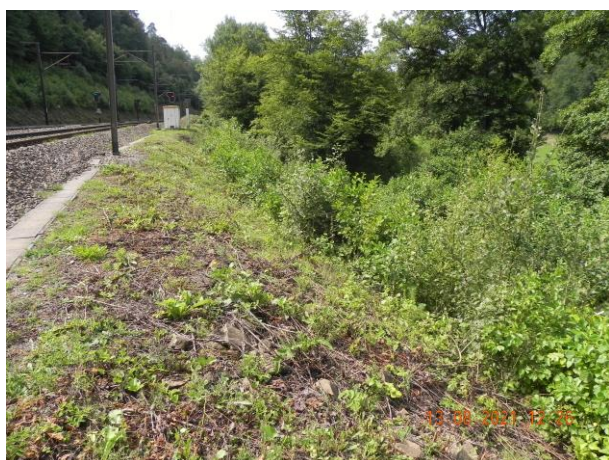
Fig. 4. – Vue de la partie sud du segment ferroviaire peu après le débroussaillage annuel, 13 août 2021 (photo : A. REMACLE).
