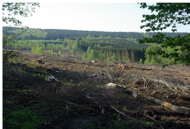
Fig. 6. – Travaux préparatoires au contournement de Couvin, septembre 2013. (Photo Ph. RYELANDT)
