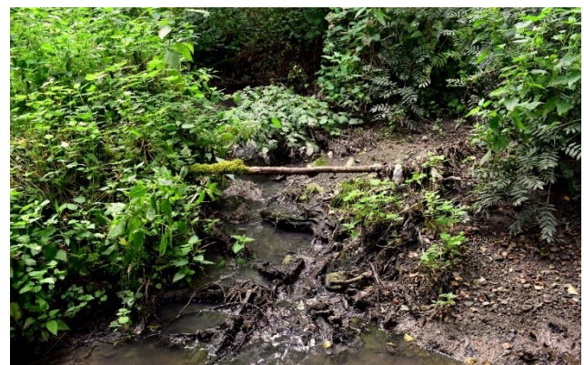
Fig. 7. Arrivée de l'égout de Falmagne en CP16.
