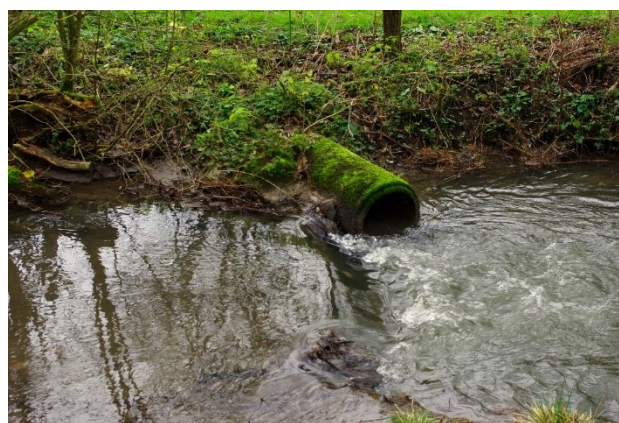
Fig. 10. – Arrivée d'un égout entre CP18 et CP19.
