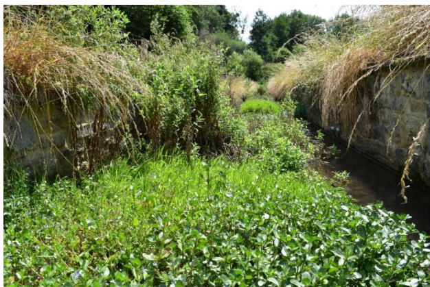
Fig. 8 – Relevé CP14 entre deux murs en moellons.
