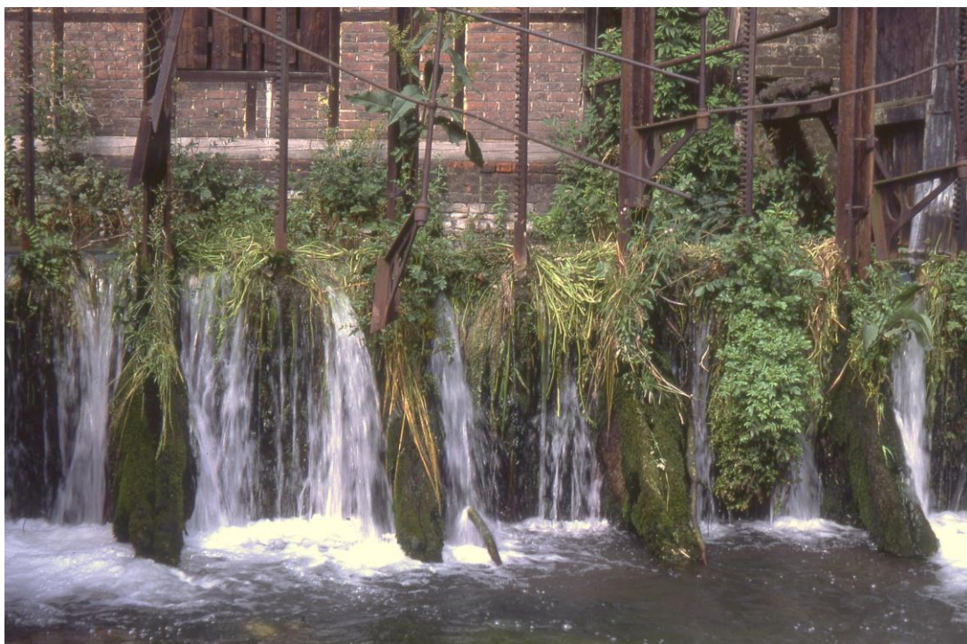
Fig. 5. – Rhynchostegium riparoides sur les piles métalliques du barrage de Nampty, sur la Selle (affluent de la Somme) (Photo J.R. WATTEZ).
