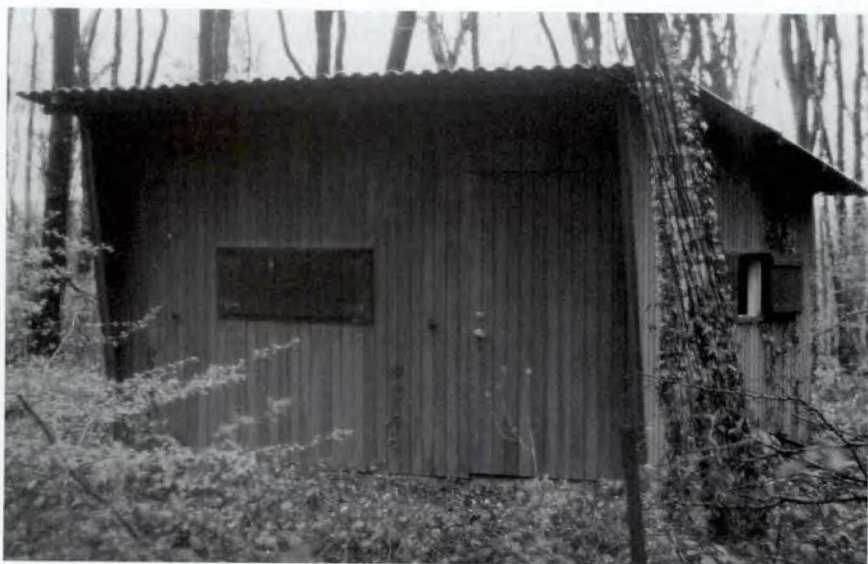
FIG. 6. — Le petit bâtiment technique. Photo M. Rouard.
