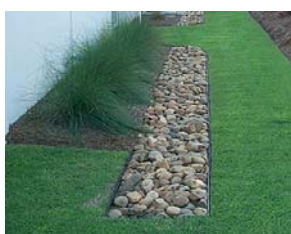
Fig. 2. Șanț de infiltrare
