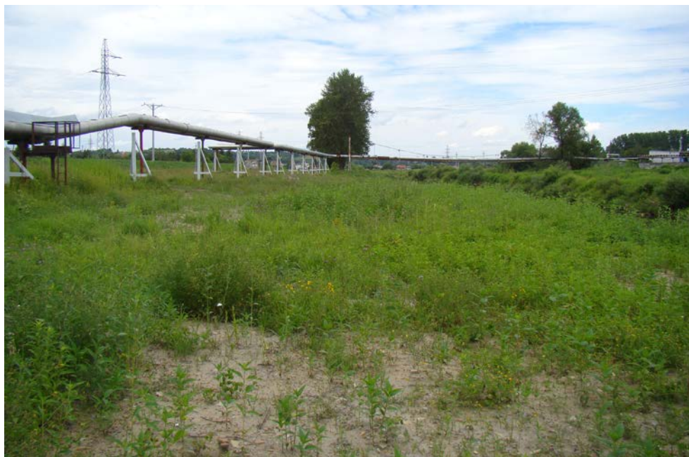
Ryc. 10. Nagie podłoże, zarastane przez Helianthus tuberosus , około 30 dni po zakończeniu prac budowlanych
