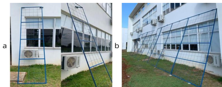
Figura 3: Protótipo inicial e estrutura instalada.
