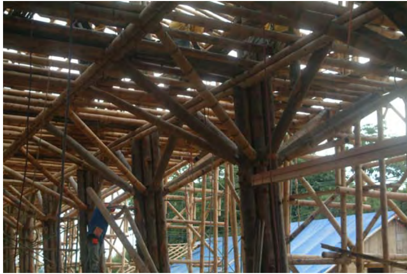
210. Detalle uniones y diagonales entrepiso del edificio (Foto Simón Vélez)
