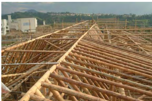
215. Detalle construcción estructura de guadua Cubierta (Foto Simón Vélez)
