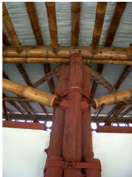
Unión Viga guadua-Columna
