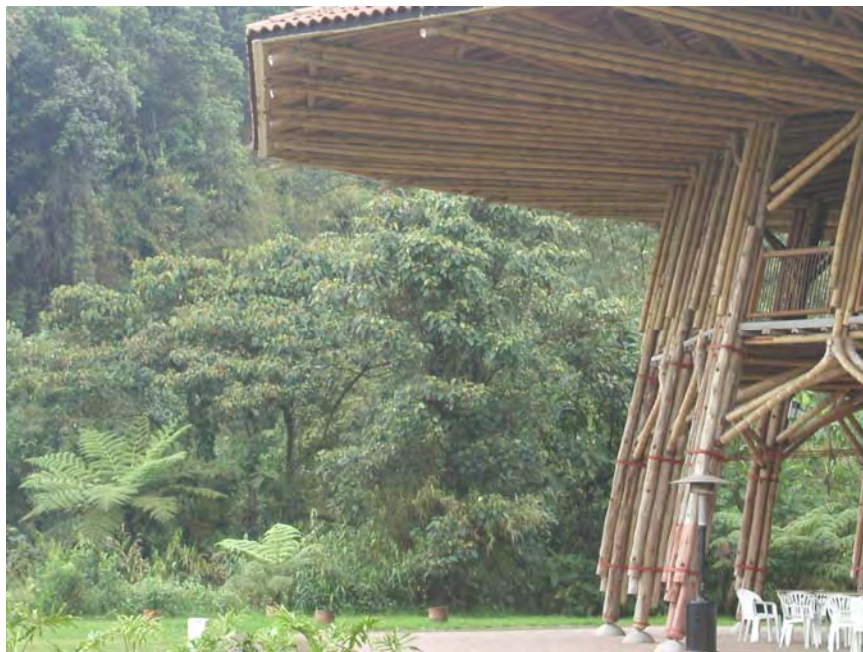
176. Vista Parcial del Pabellón ZERI Construido en Manizales- Colombia (Foto del autor)
