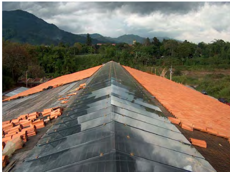
143. Cubierta sede Carder-2004 (foto del autor)
