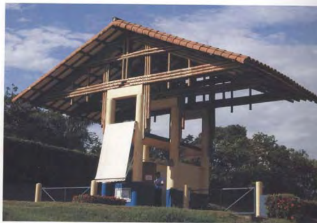
153. Vista Portería acceso voladizo de 6.00m.
