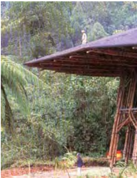
178. Vista parcial de aleros de 7.30mts. Manizales-Colombia
