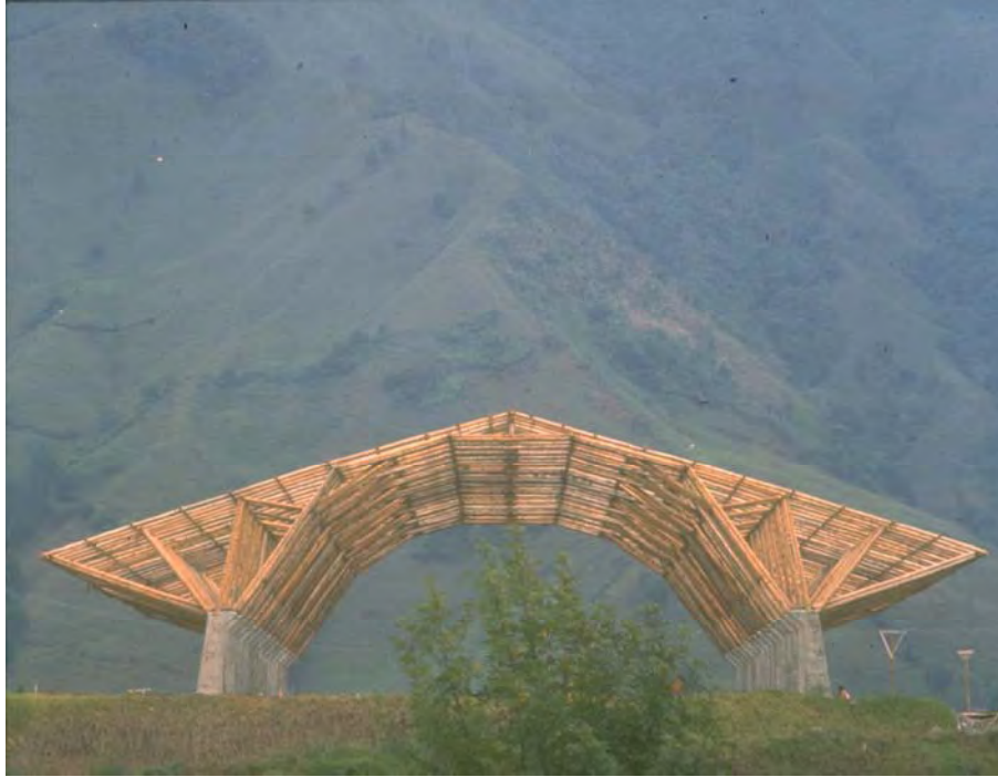
107. Estructura mixta columnas de hormigón y estructura de guadua
