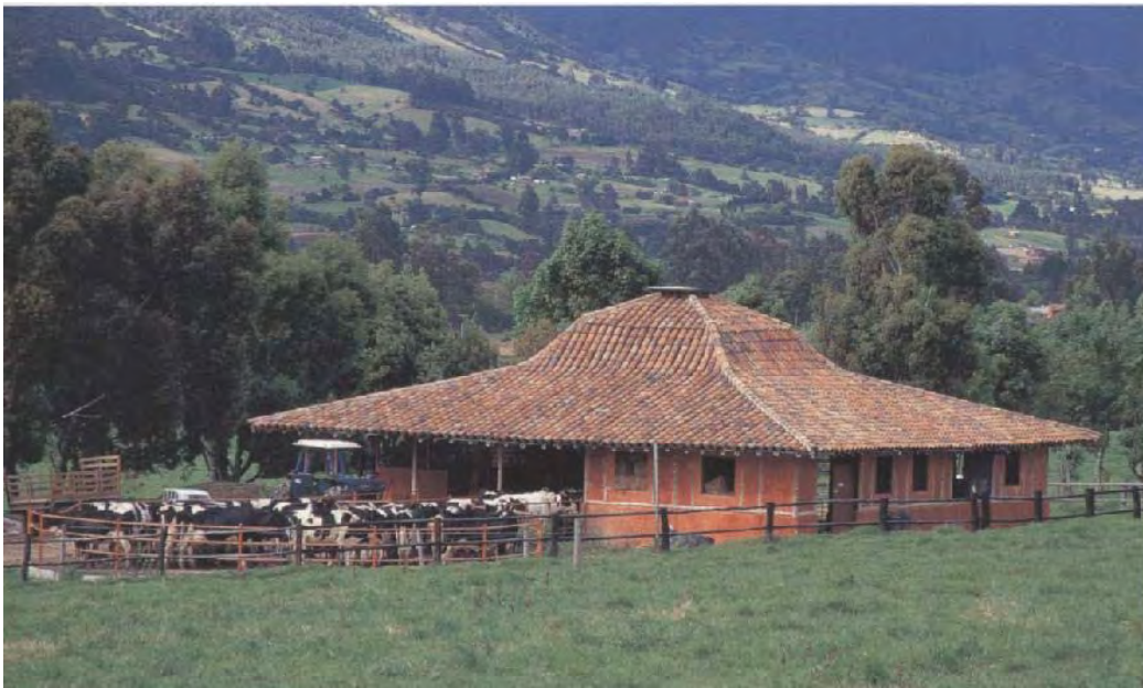
164. Vista Exterior Establo en Cundinamarca
