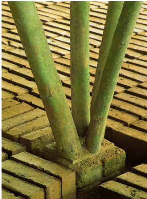
111. Uniones tradicionales de columnas de guadua con apoyos en ladrillo
