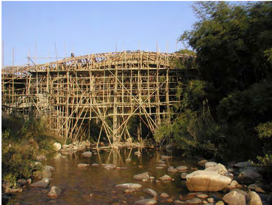
249. Construcción de puente bambú en China Simón Vélez-2005
