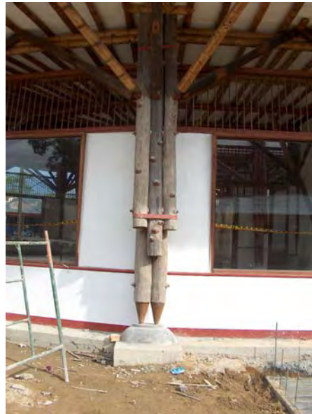
211. Detalle de un portico tipo de la estructura (Foto del autor)
