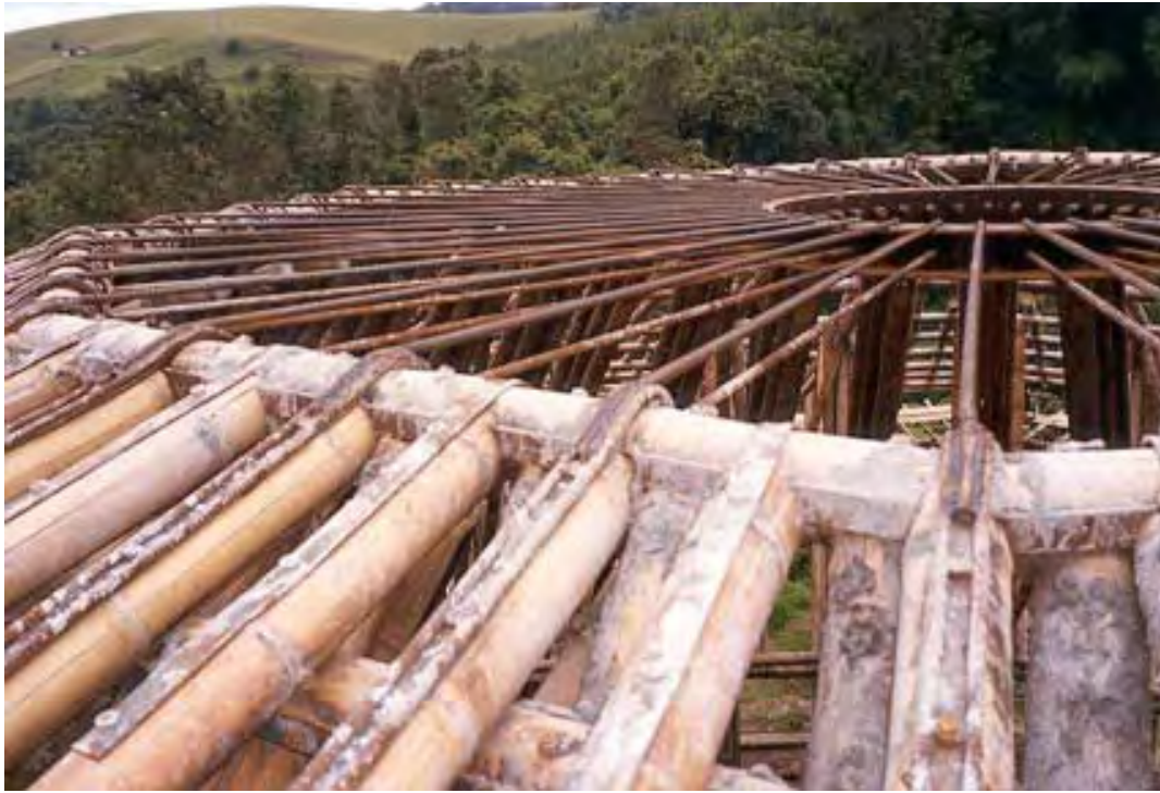
186. Detalle anillo cubierta Manizales-Colombia
