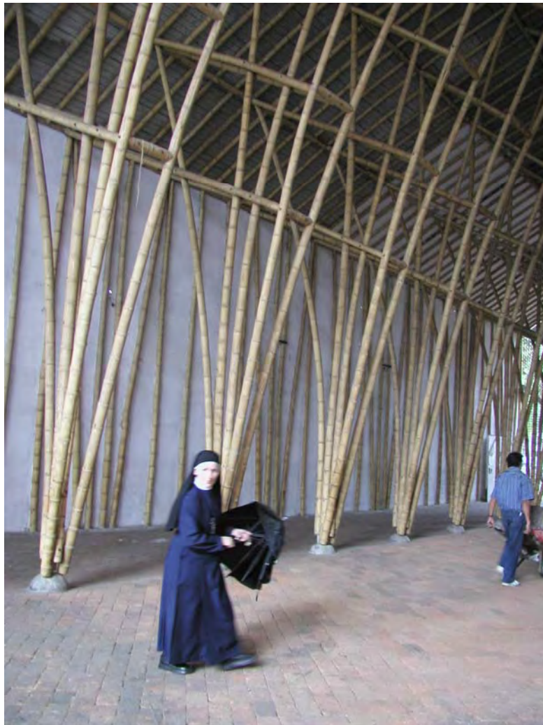
226. Vista parcial estructura de guadua
