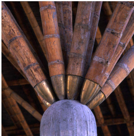
125. Unión columna hormigón-guadua
