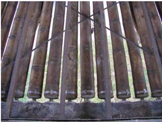
242. Detalle Uniones vigas apoyos
