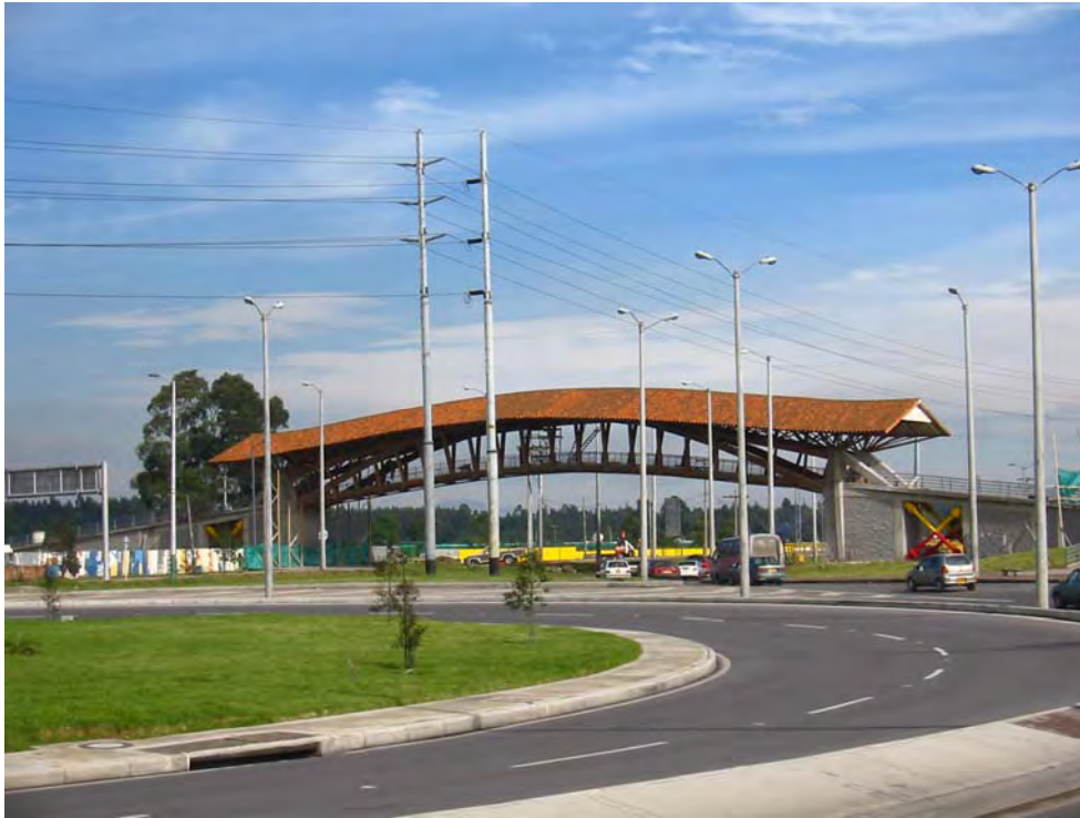
234. Vista general del puente Jenny Garzón
