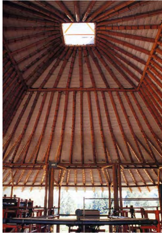
166. Vista interior Establo en Cundinamarca
