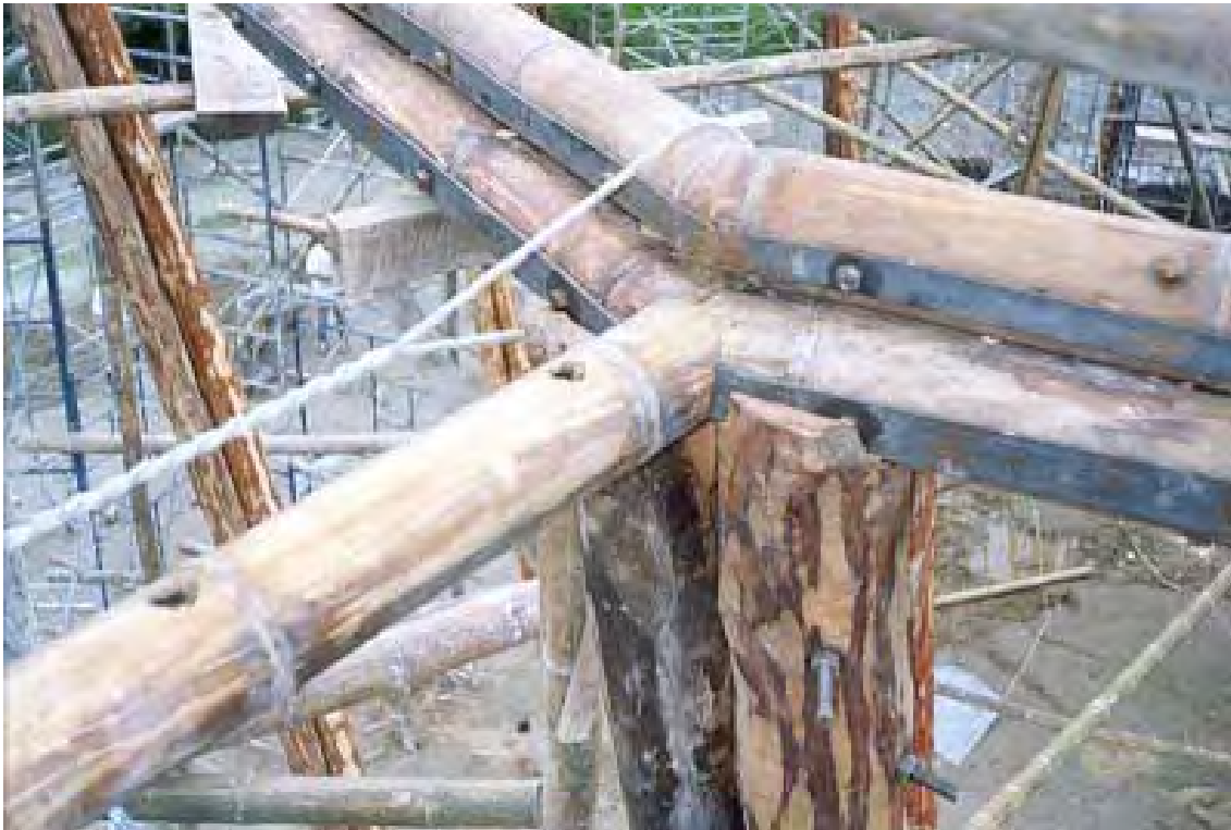
185. Detalle unión columna arboloco y vigas aéreas de guadua Manizales- Colombia
