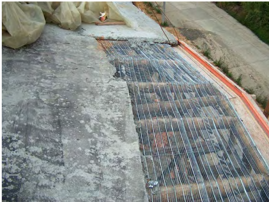
141. Construcción cubierta-Carder 2004 (foto del autor)
