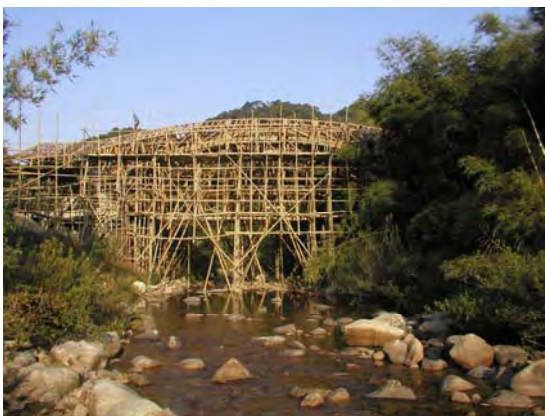
251. Construcción de puente bambú en China Simón Vélez-2005
