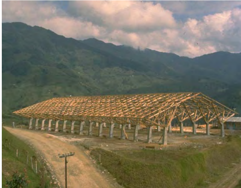
131. Estructura de cubierta en guadua con apoyos en concreto
