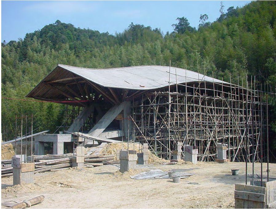
254. Construcción de puente bambú en China Simón Vélez-2005
