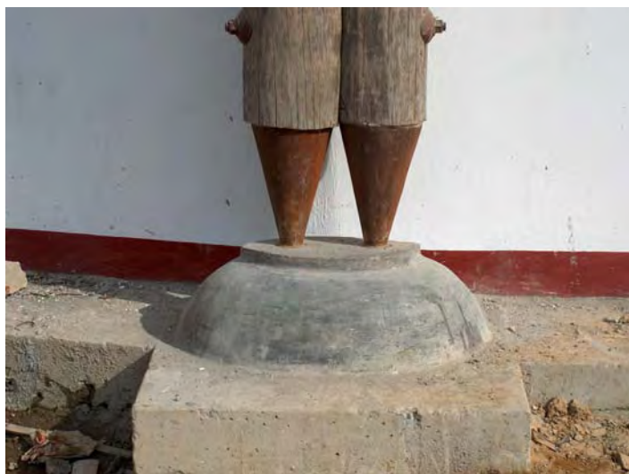
207. Detalle unión pedestal y columna de mangle
