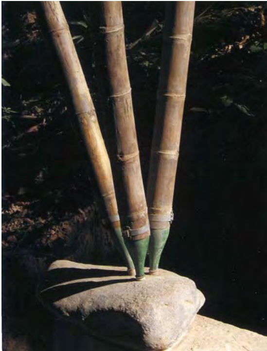
129. Detalles de uniones actuales de obras de Simón Vélez
