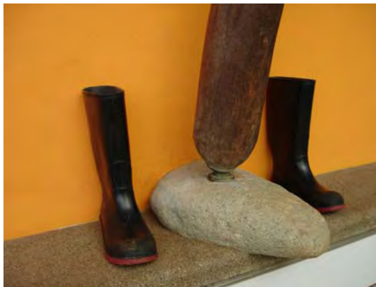
128. Detalle apoyo columna de madera y pedestales piedra de río
