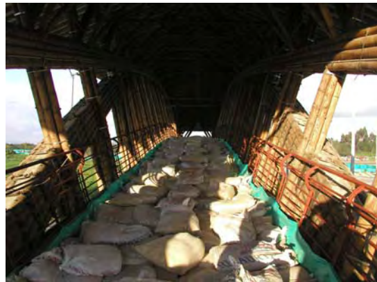
Pruebas de carga estructura del puente
