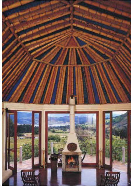
108. Vista parcial interior estructuras de cubiertas en guadua Simón Vélez
