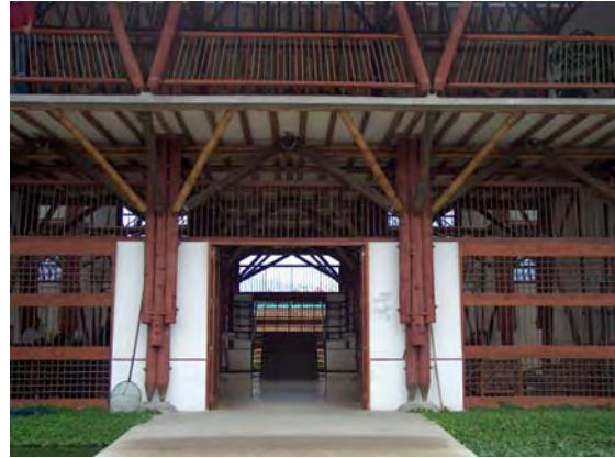
Detalle cerramiento exterior edificio
