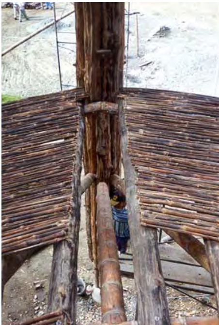
184. Detalle construcción entrepiso Manizales- Colombia (Foto Simón Vélez)
