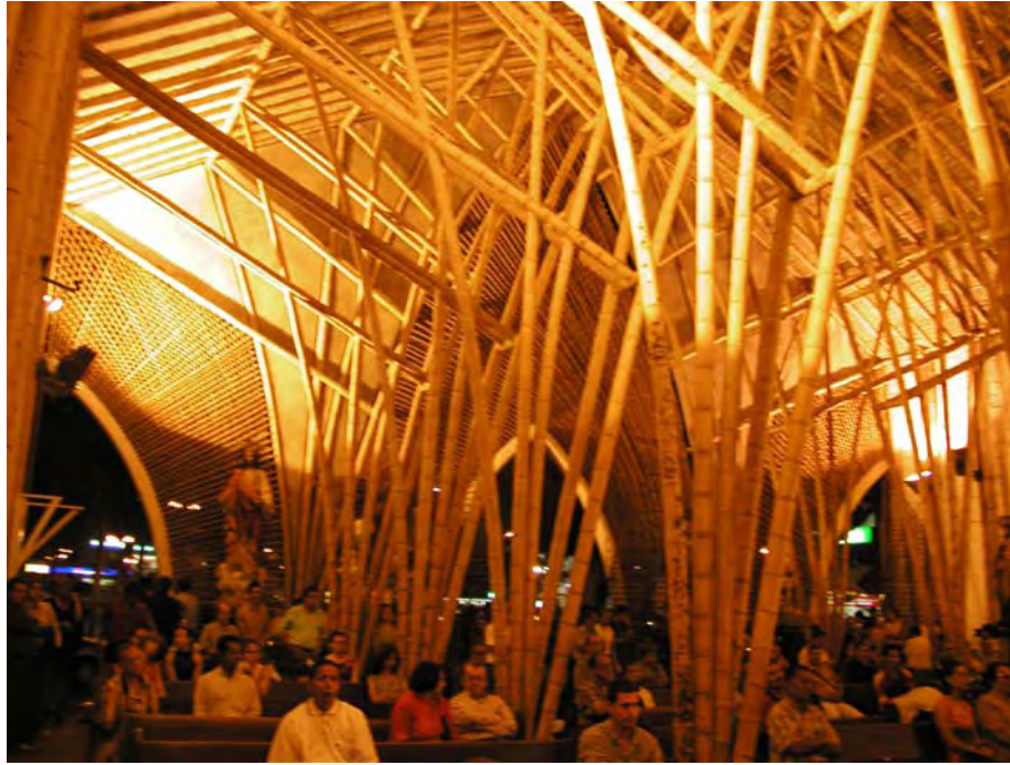
227. Vista parcial estructura de guadua
