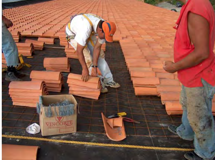
142. Instalación de la teja de barro española (foto del autor)
