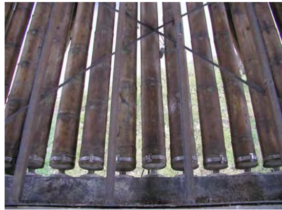
127. Detalle Unión diagonales y puntos de apoyo y forjado del puente en guadua Puente Jenny Garzón 2003
