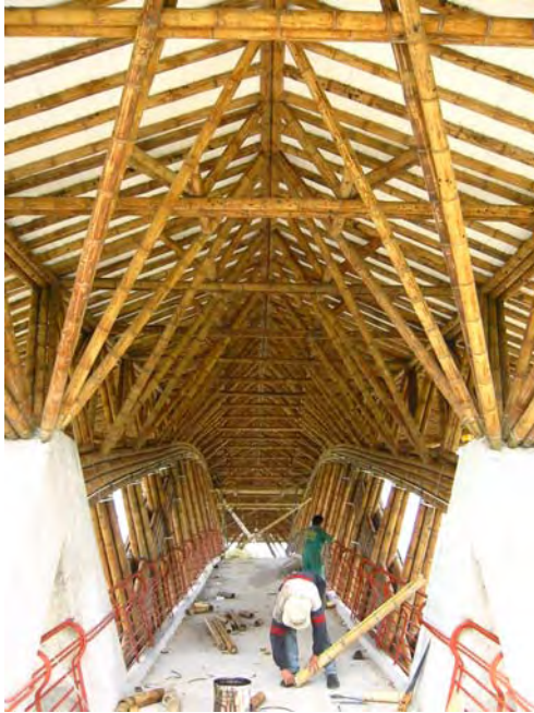
240. Vista parcial estructura de cubierta
