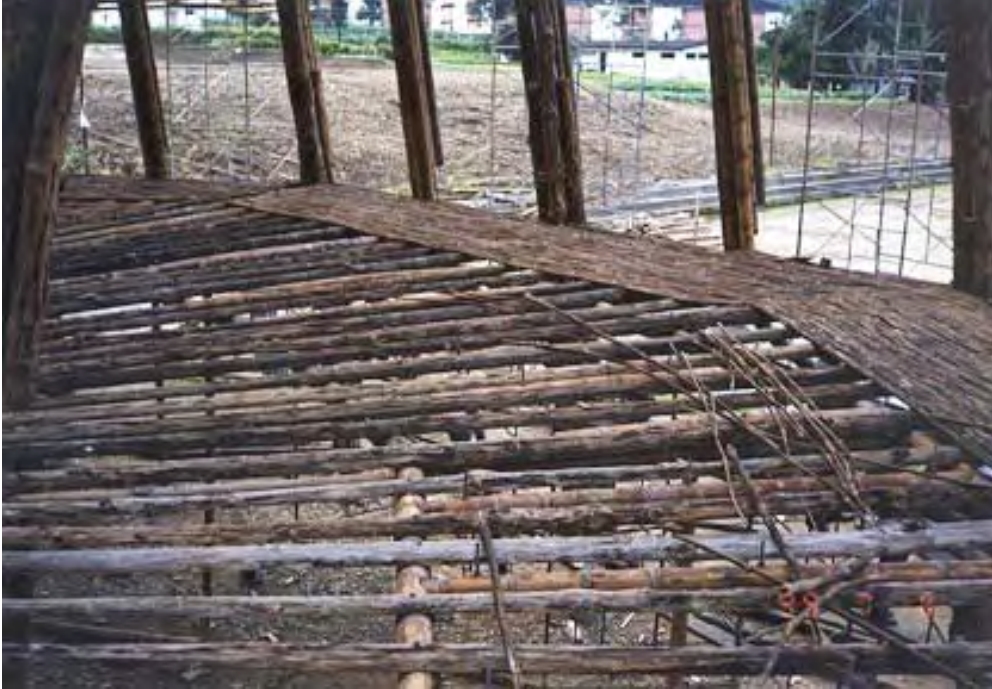
183. Detalle construcción entrepiso Manizales- Colombia (Foto Simón Vélez)
