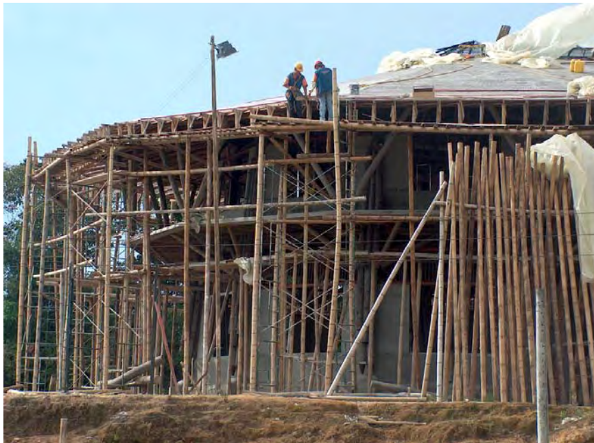
139. Proceso constructivo cubiertas Sede Carcer 2004 (foto del autor)
