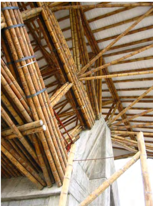
241. Llegada de vigas principales-apoyos
