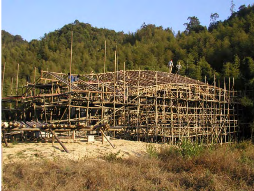
252. Construcción de puente bambú en China Simón Vélez-2005
