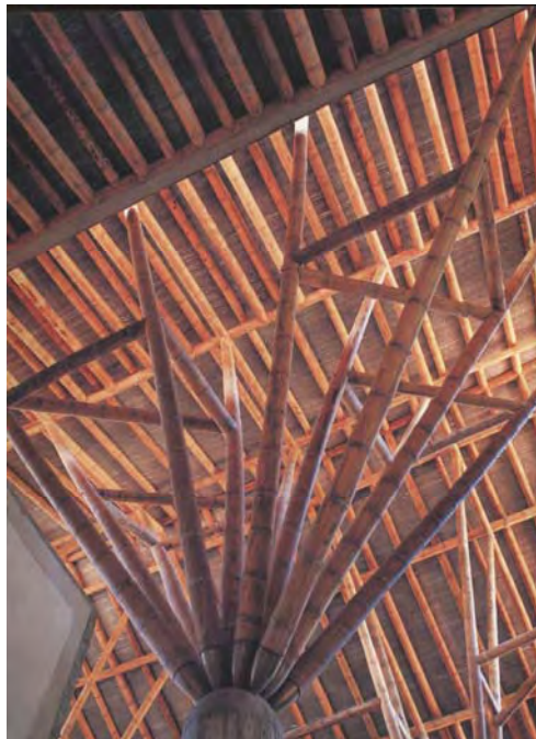
126. Unión apoyo hormigón-guadua
