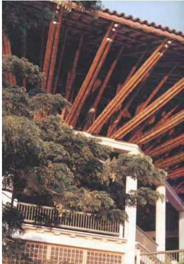
152. Vista parcial cubierta.
