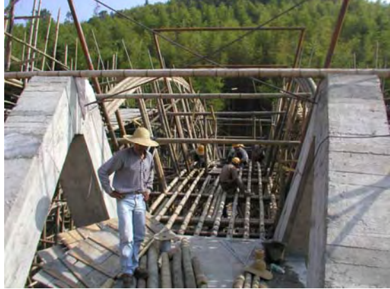
248. Vista parcial estructura en hormigón y bambú Simón Vélez-2005
