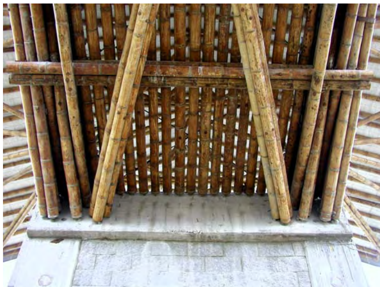
243 Vista inferior Uniones vigas estructura forjado puente
