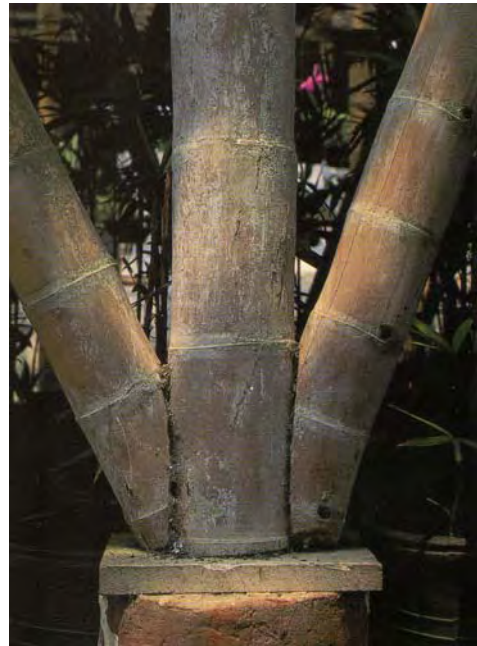
111. Uniones tradicionales de columnas de guadua con apoyos en ladrillo
