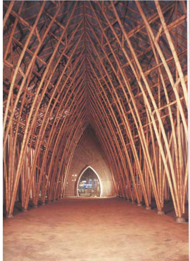
Vista interior de la iglesia
