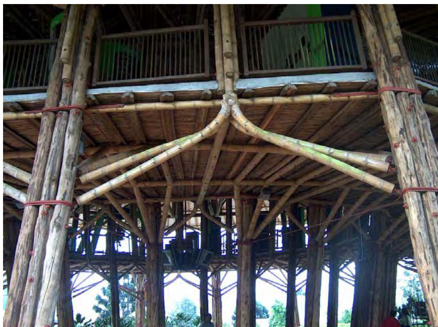
190. Detalle uniones guadua-arboloco Manizales- Colombia (Foto del autor)
