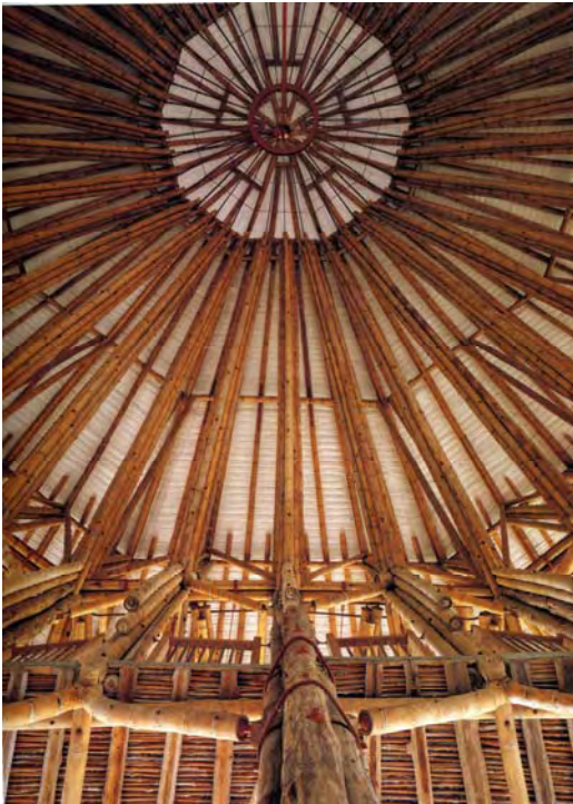
182. Detalle interior cubierta pabellón
