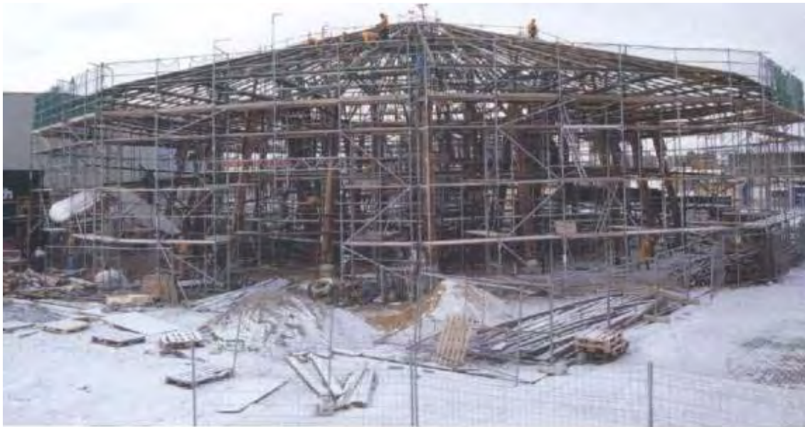
180. Vista general Armado y montaje Estructura Pabellón Hannover-Alemania
