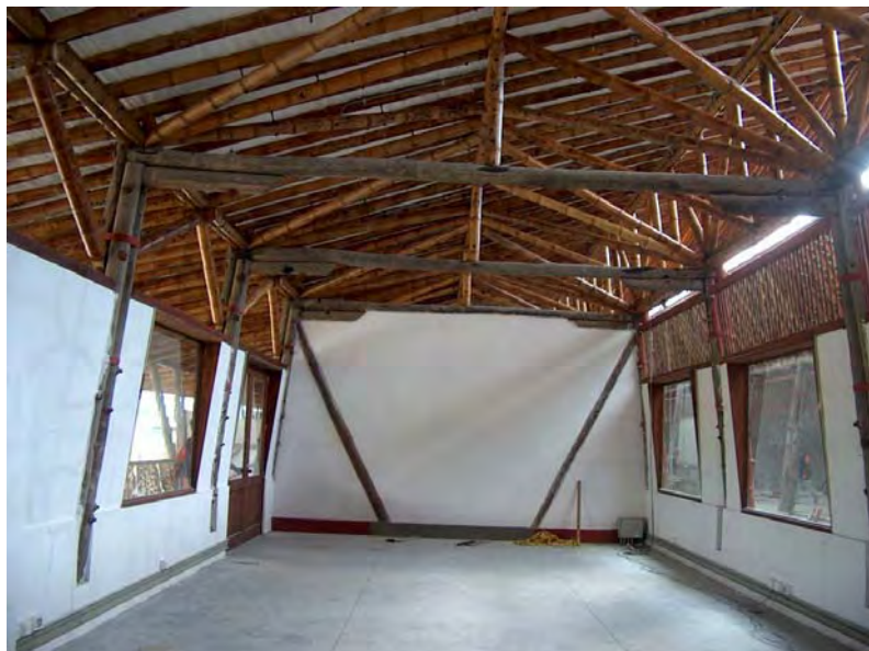
213. Muros en sistema tipo pladur (Foto del autor)
