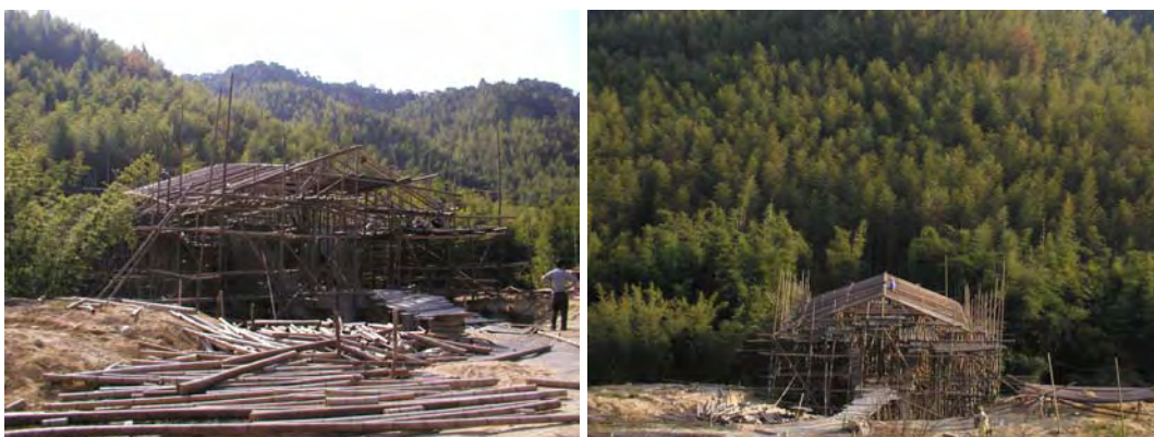
253. Vista parcial estructura del puente en bambú–China 2005
