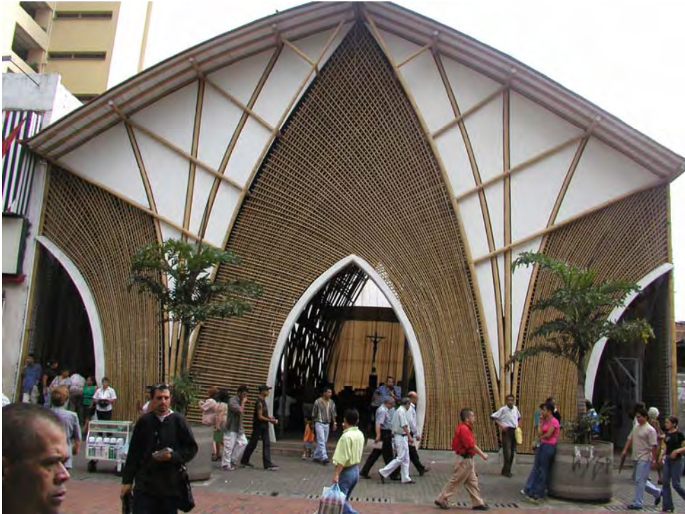
223. Vista exterior de la iglesia
