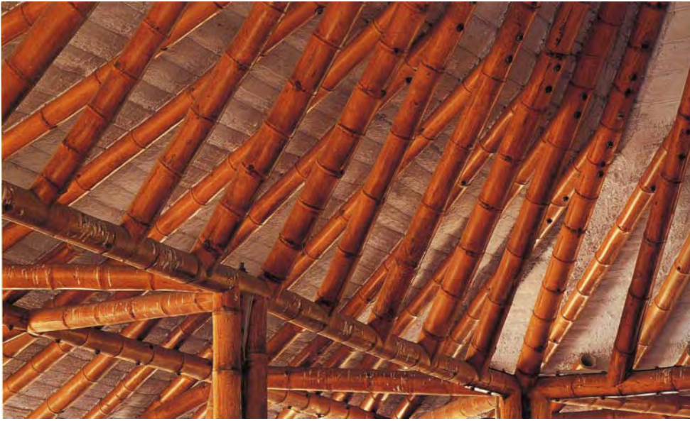
99. Estructura en guadua de establo de ganado en Tenjo-Cundinamarca
