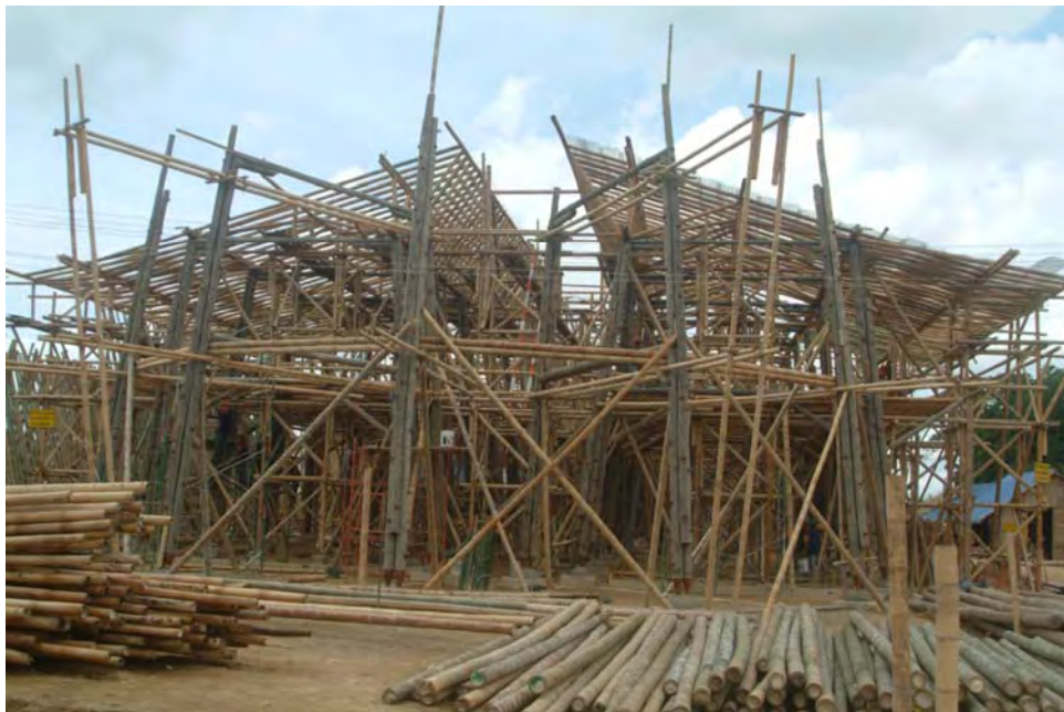
205. Vista parcial de la estructura Edificación (Foto Simón Vélez)
