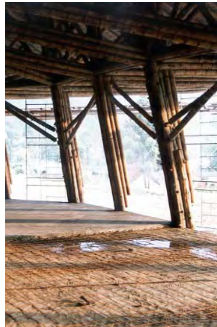
184. Detalle construcción entrepiso Manizales- Colombia (Foto Simón Vélez)
