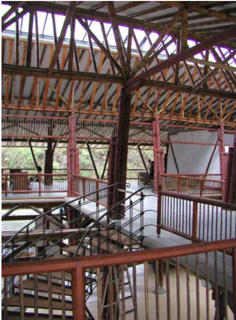
219. Vista interior edificio 2º piso
