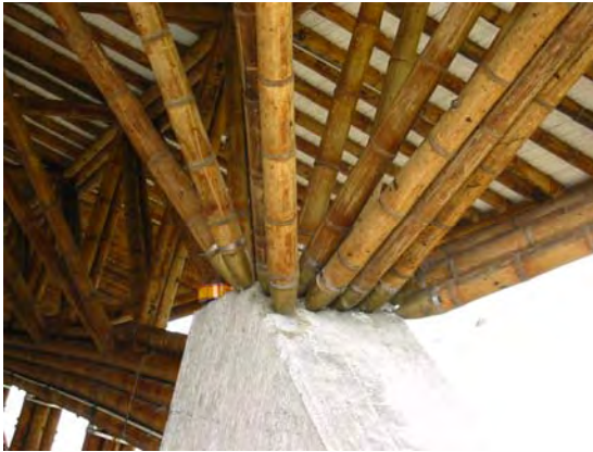
127. Detalle Unión diagonales y puntos de apoyo y forjado del puente en guadua Puente Jenny Garzón 2003
