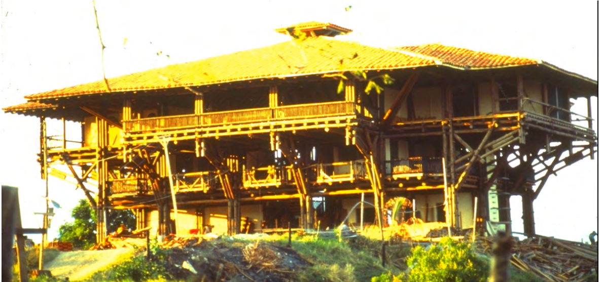
89. Vista exterior vivienda en madera Simón Vélez-1985
