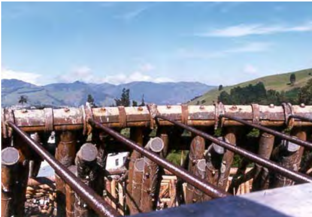
187. Detalle anillo cubierta Manizales-Colombia
