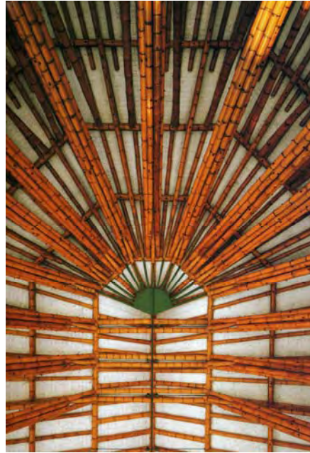
108. Vista parcial interior estructuras de cubiertas en guadua Simón Vélez
