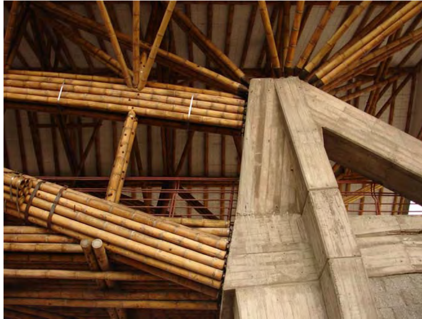
125. I Unión apoyo hormigón- vigas de guadua
