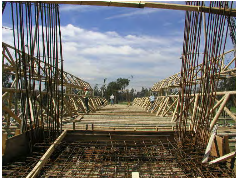
240. Construcción de los puntos de apoyo y rampas de acceso
