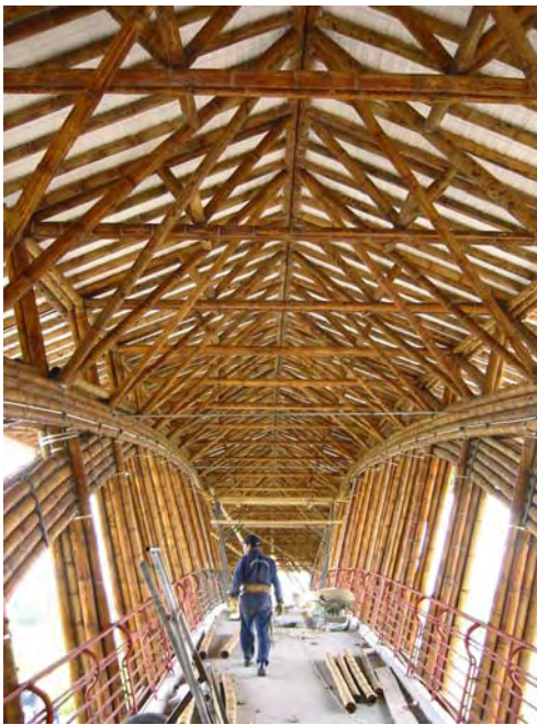
243. Vista interior del puente
