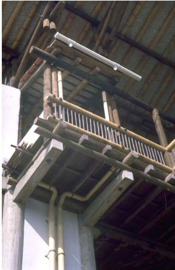
130. Estructura mixta de madera-guadua S. Vélez 1994
