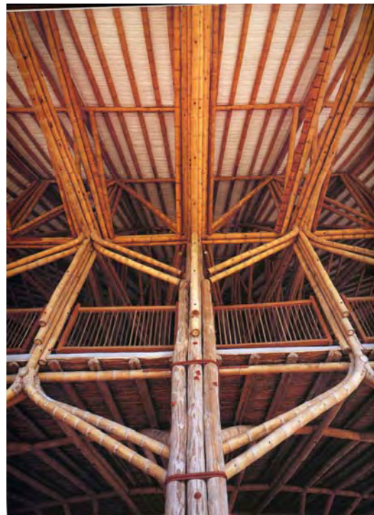
Detalle columnas en madera aliso
