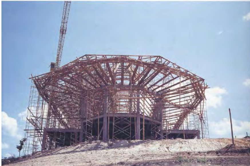
139. Proceso constructivo estructura cubierta en guadua-Peñalisa 1997
