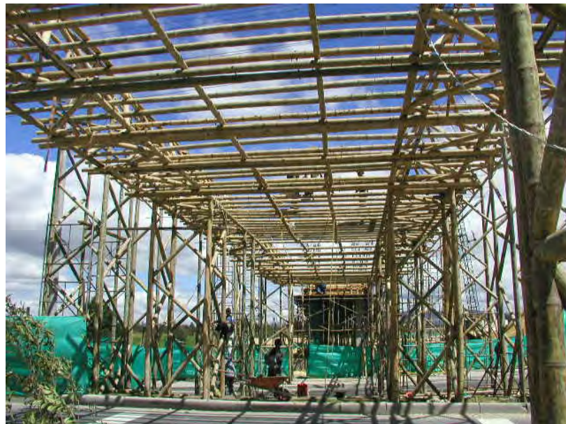
239. Proceso de construcción y montaje de andamios de guadua
