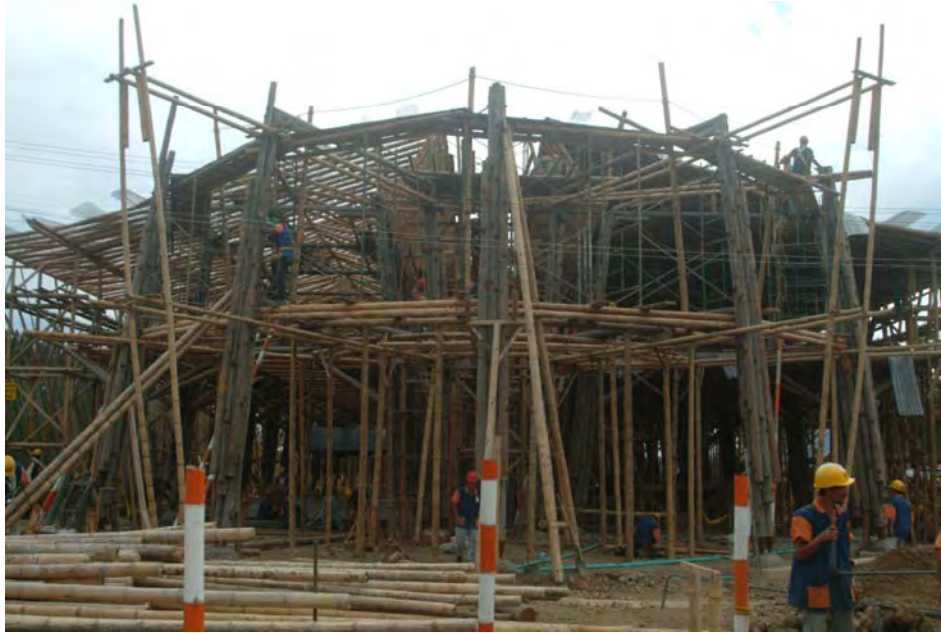
204. Vista parcial de la estructura Edificación (Foto Simón Vélez)
