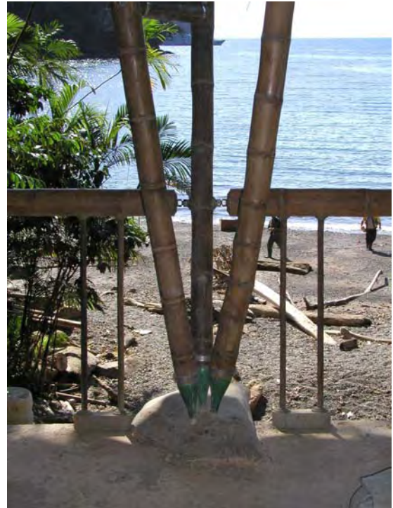
129. Detalles de uniones actuales de obras de Simón Vélez
