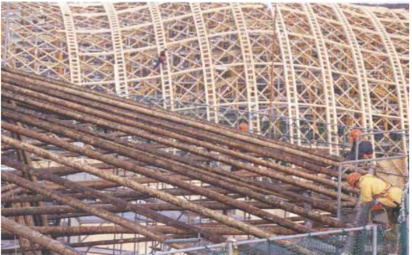
198. Vista general Armado y montaje Estructura Pabellón Hannover-Alemania
