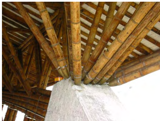
244. Uniones Vigas de guadua y estructura de apoyo en concreto
