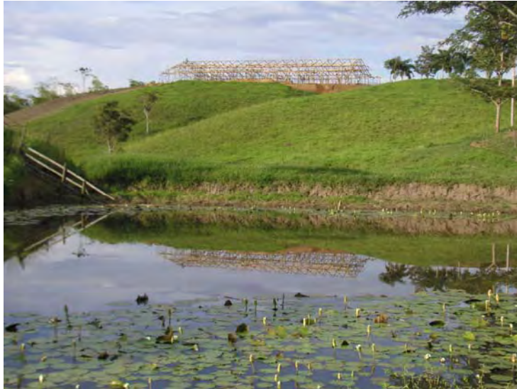
246. Vista general estructura de bambú de hotel ecológico en China
