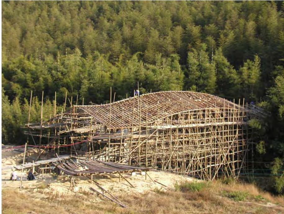
250. Construcción de puente bambú en China Simón Vélez-2005
