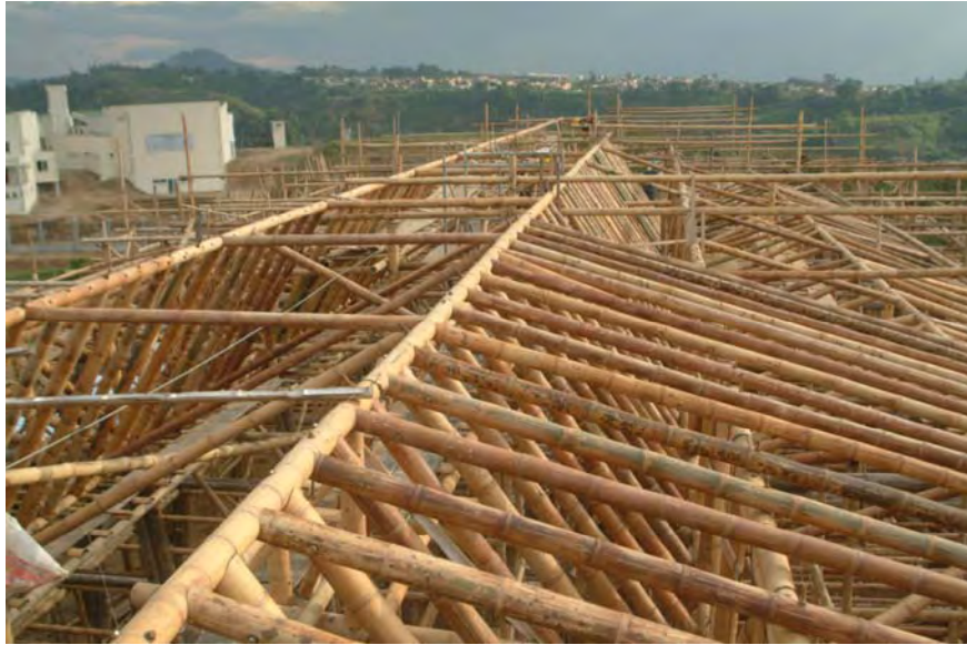
140. Proceso constructivo de cubierta estructura en guadua
