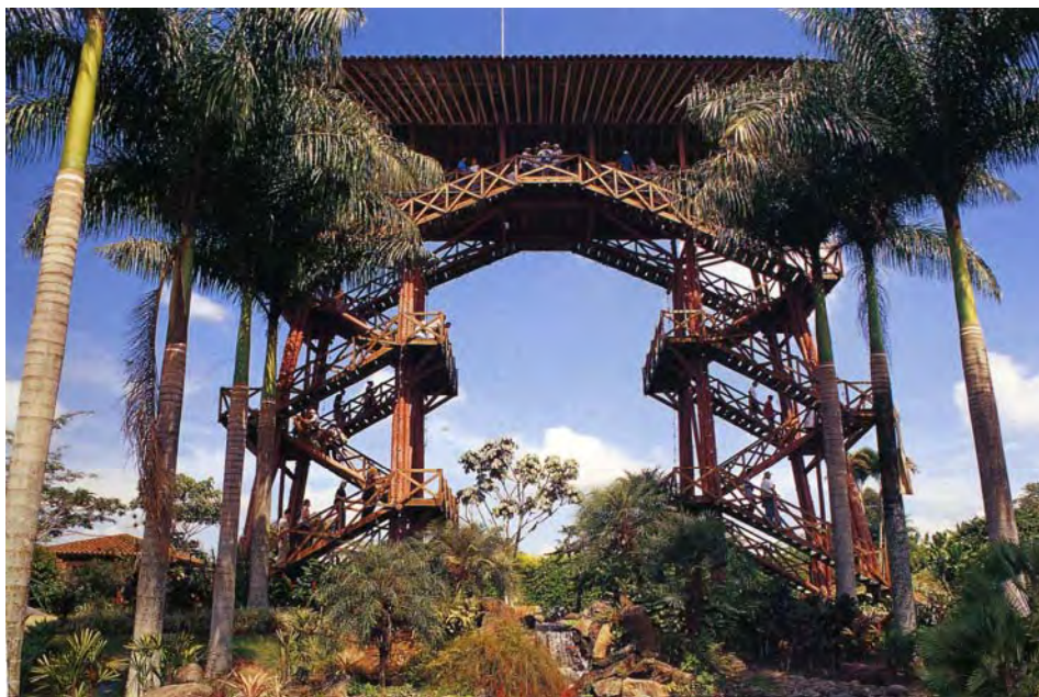
100. Estructura mixta columnas en mangle cubierta en guadua Simón Vélez 1995
