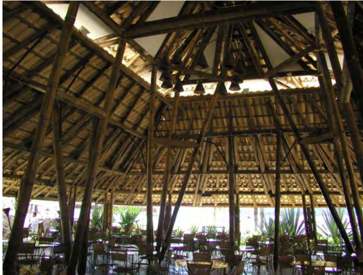
170. Vista interior Estructura de Cubierta
