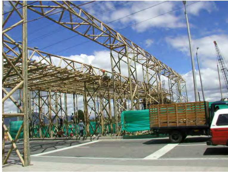
238. Montaje de andamios y estructura tridimensional de guadua
