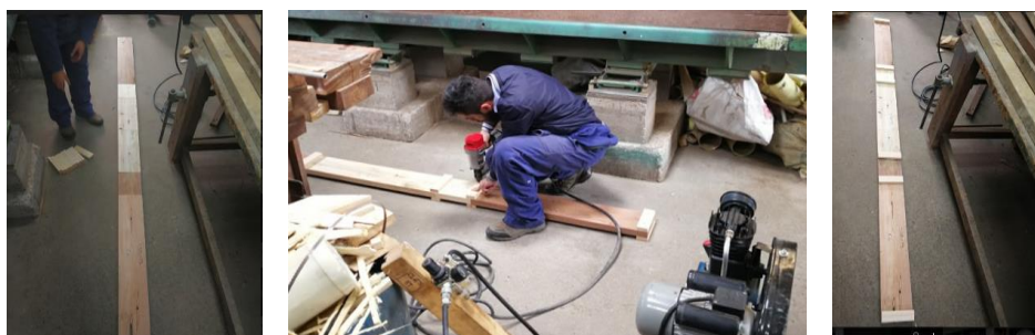
Figura 34. Ensamble de vigas.
