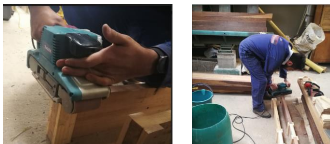
Figura 35. Proceso de lijar uniones para garantizar uniformidad en la superficie de la viga
