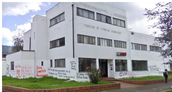
Figura 6. Edificio 238 - Universidad Nacional de Colombia sede Bogotá.
