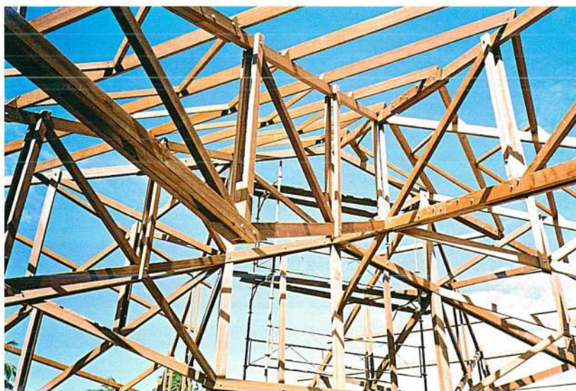
Charpente en Angélique boulonnée. Pièce de grande longueur soumise à des contraintes de flexion. Wood structure made of bolted Angelique. Very long piece subject to bending stresses.
