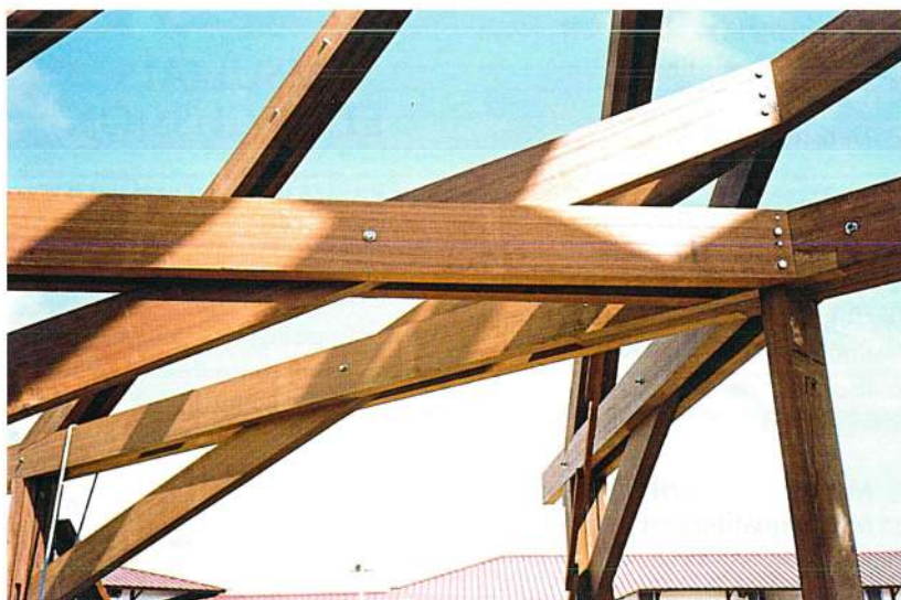
Pièces de structure en Angélique (système poteau-poutre). Angelique structural elements (pole-beam system).
