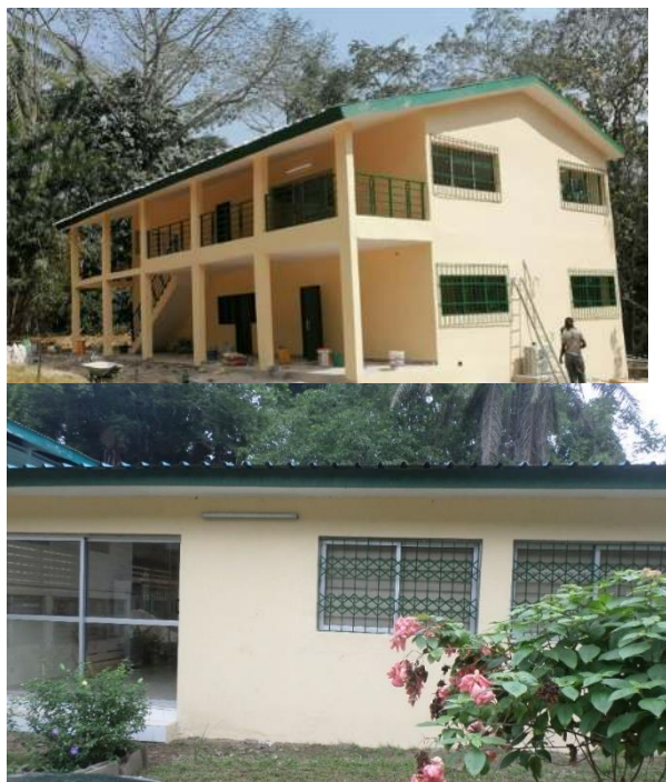
Photo 2 et 3. Bâtiment principale et bibliothèque et bâtiments abritant la salle de cours,
