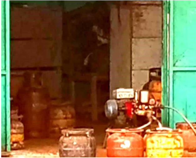
Figure II: une station artificielle de pompage de gaz butane Prise de vue : A. YEDAGNE, aout 2023.
