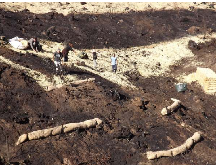
Figura 3. Traballos de estabilización do solo, tras o incendio de 2017.
